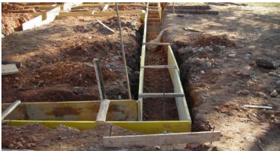
Figura 48. Ilustración sobre el montaje de los encofrados.
