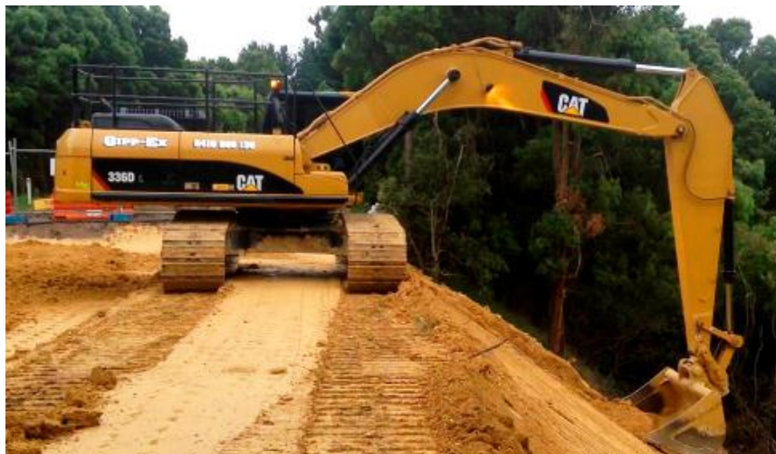
Figura 42. Ilustración de la limpieza de la masa vegetal.
