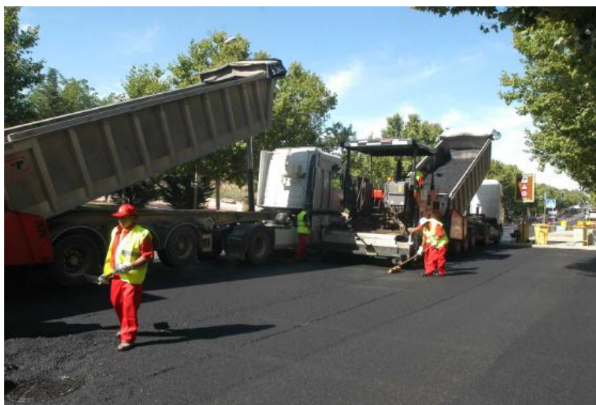
Figura 48. Ilustración sobre el suministro de la capa de mezcla bituminosa.
