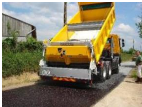
Figura 46. Ilustración sobre el suministro de la capa de zahorra artificial.
