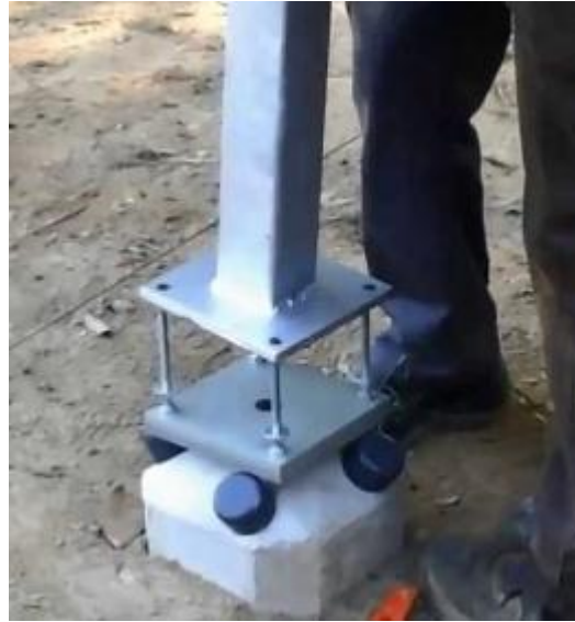
Figura 50. Ilustración sobre la colocación de los pilares.
