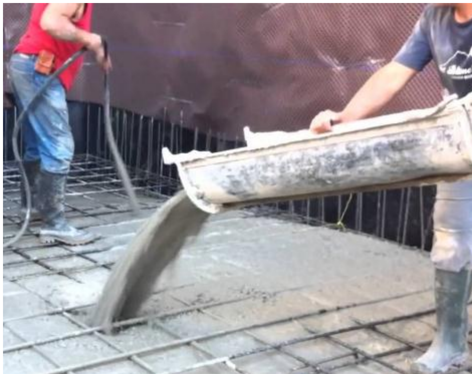
Figura 49. Ilustración sobre el hormigonado.
