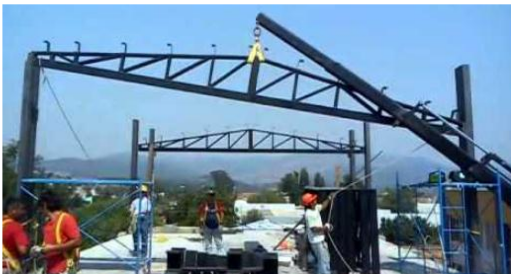
Figura 51. Ilustración sobre la colocación de los pórticos.
