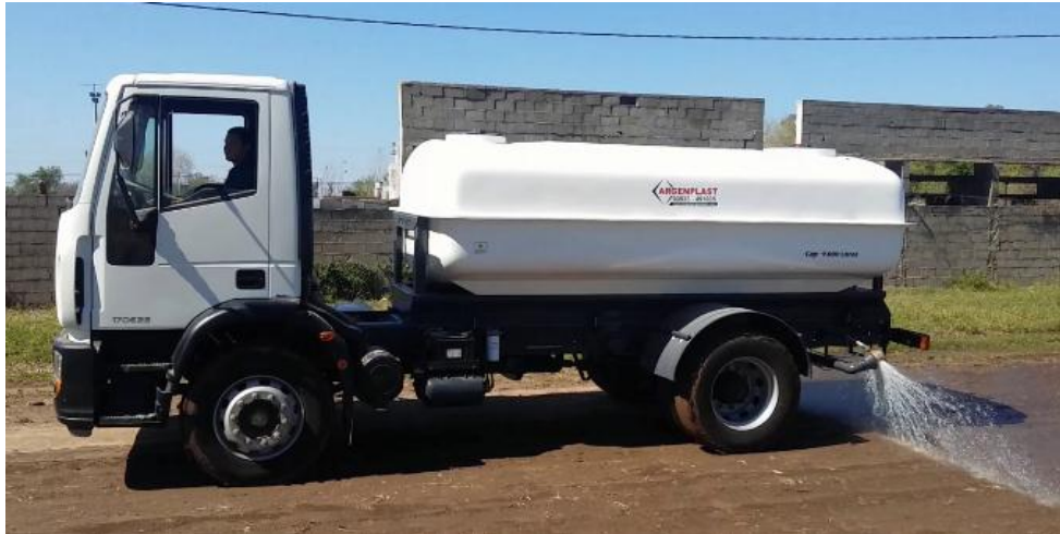
Figura 47. Ilustración sobre el riego de la zahorra.
