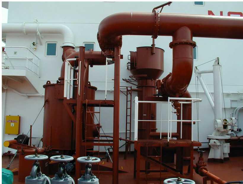
Imagen 7.- Sello, válvula no retorno y válvula manual (mil vueltas)
