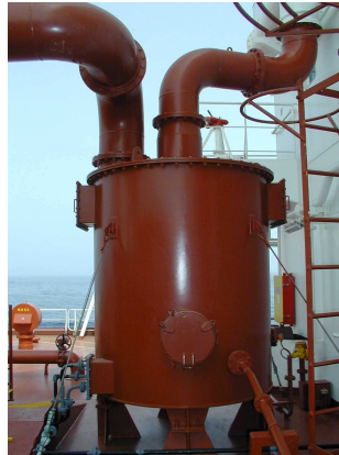
Imagen 6.- Sello de agua en cubierta
