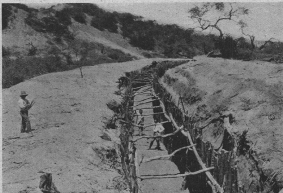
Figura 2.—Construcción de un canal para riego, en terreno arenoso.
