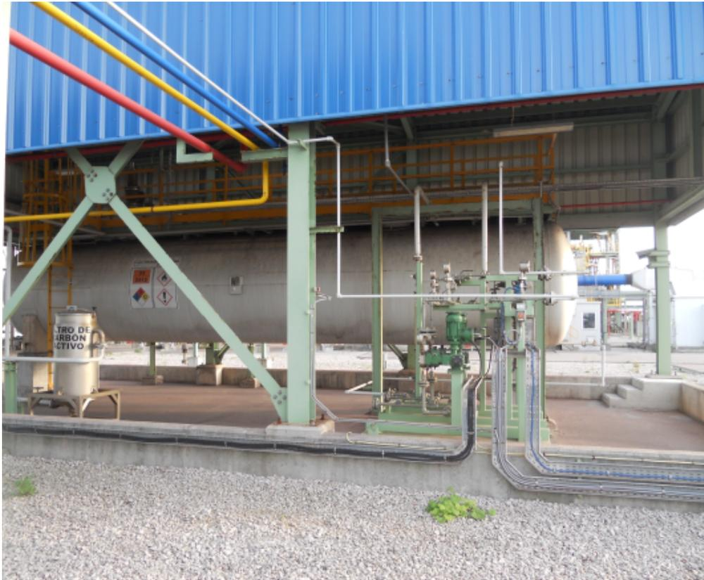
*Ilustración 37: Planta de odorización. Enagas.*
