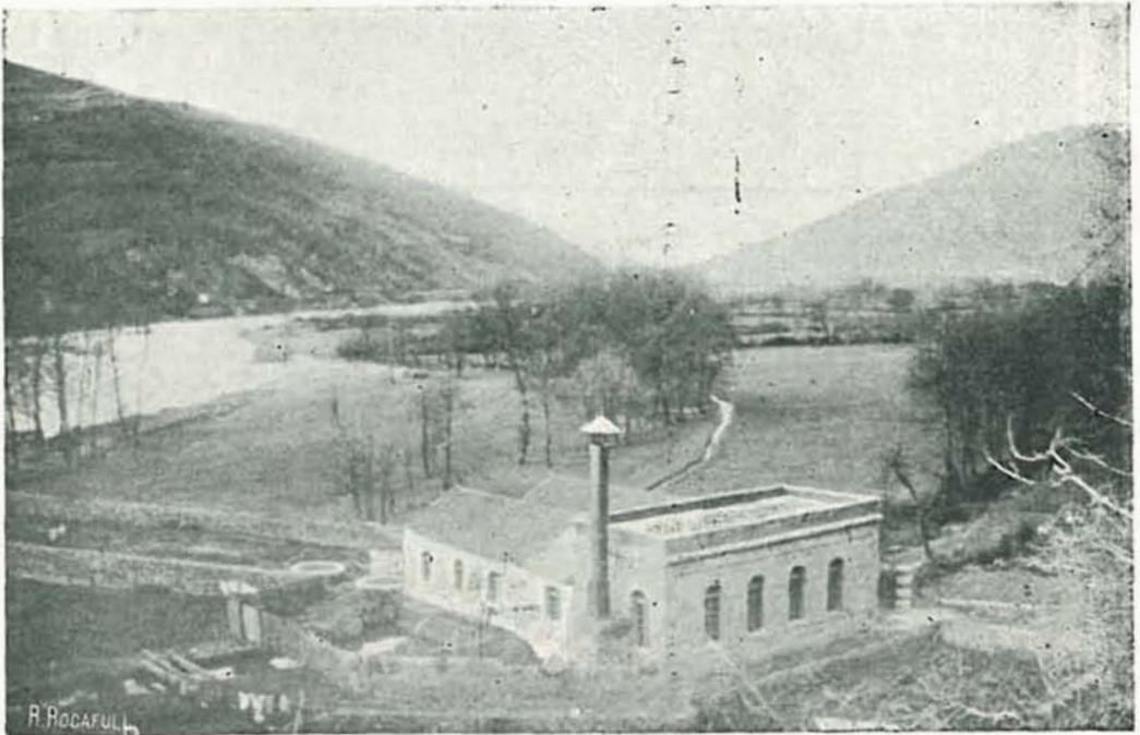
Fig. 29.—CASA DE MÁQUINAS DE MIERES.
