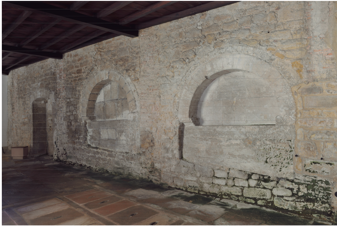
Muro de separación entre el claustro de San Pelayo y la iglesia funeraria de Santa María del Rey Casto.
