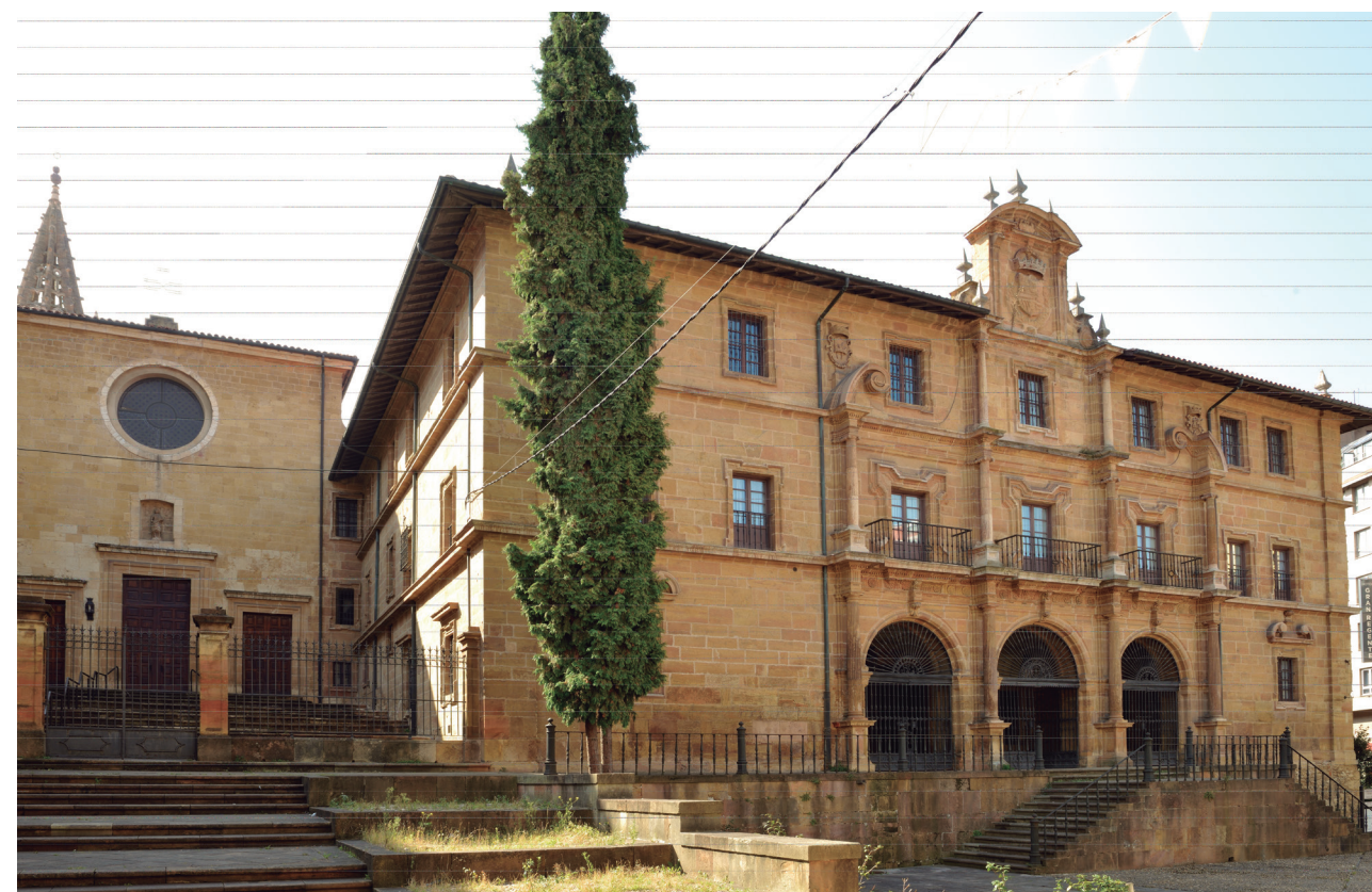
Monasterio de San Pelayo de Oviedo (estado actual).
