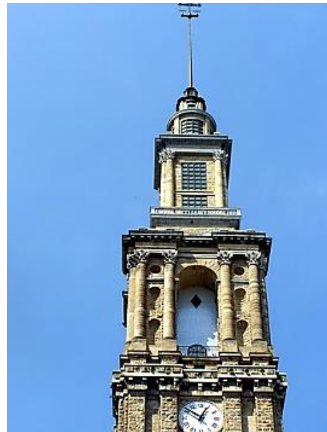
Figura 20- Vanos en forma de arco de medio punto. Plantas 14 a 16.
