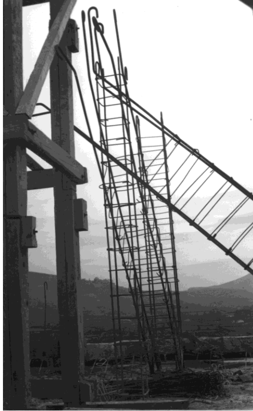
Ilustración 5- Pilares inclinados de esquina en la planta 13 (II).
