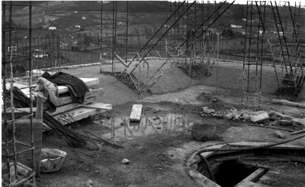
Ilustración 4- Pilares inclinados de esquina en la planta 13 (I).
