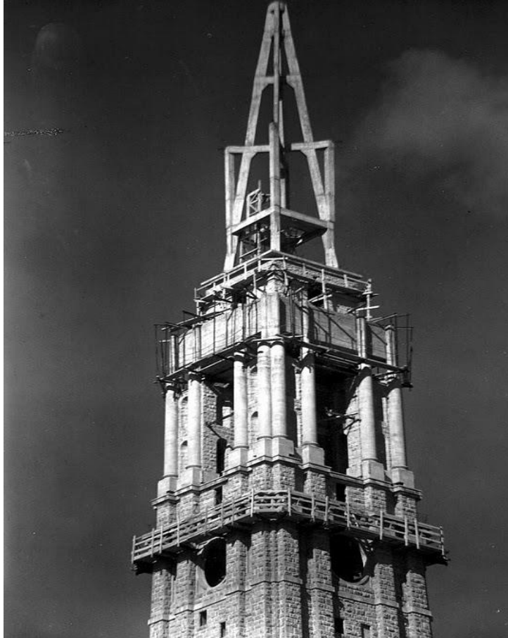
Ilustración 1- Pilares inclinados en la cúspide.
