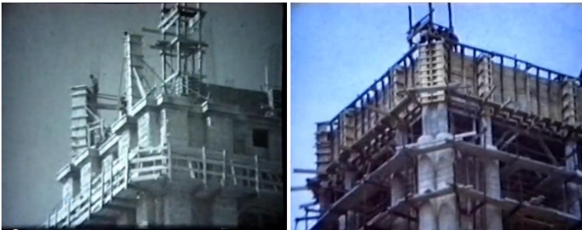
Ilustración 2- Construcción de las paredes exteriores.
