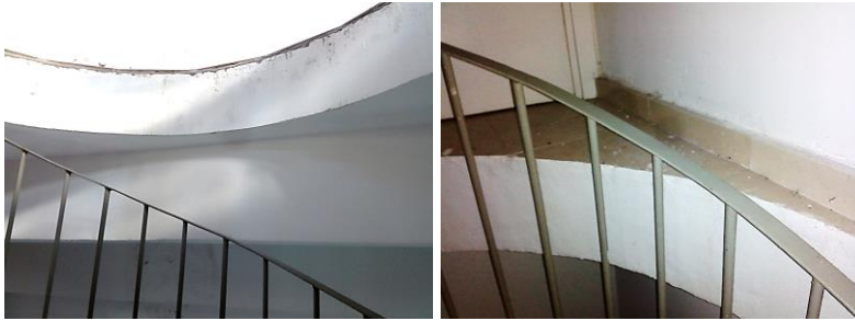
Figura 64- Espesor del forjado de la planta 14. Medición 2017.
