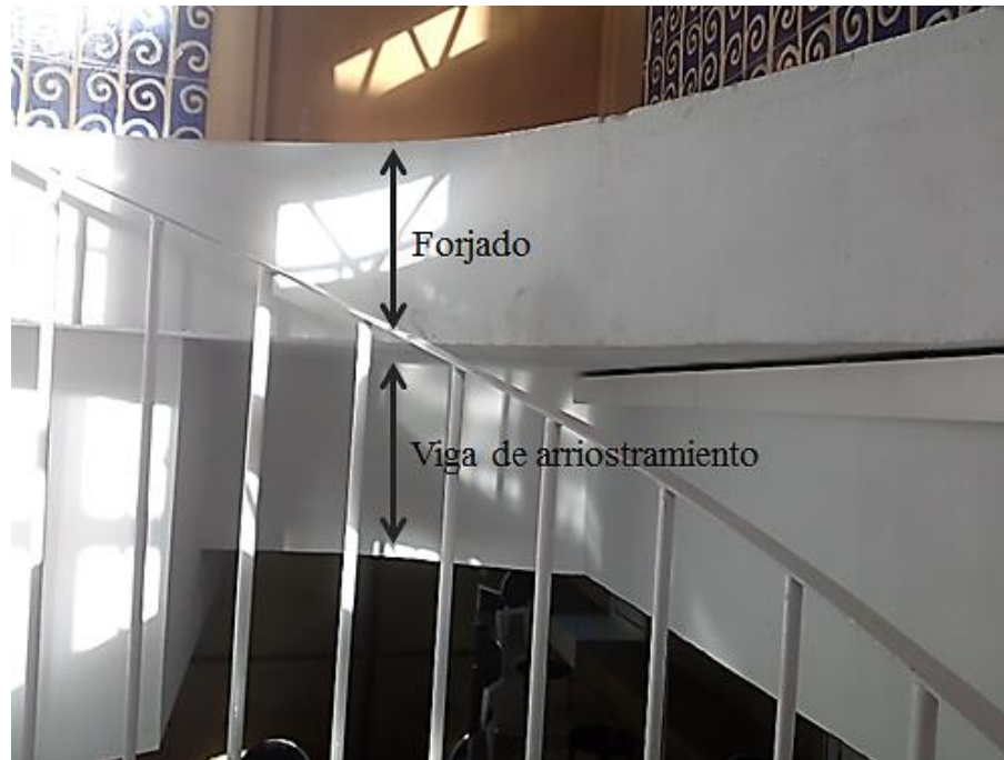
Figura 66- Viga de arriostramiento en la planta 13. Medición 2017.
