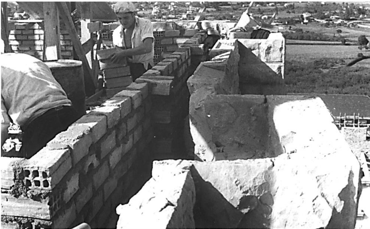
Figura 65- Construcción de paredes exteriores.
