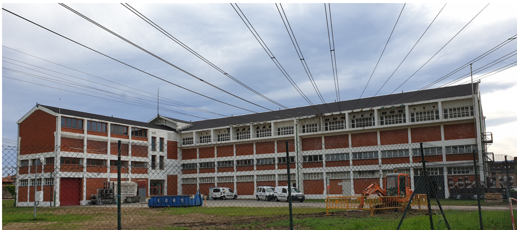
Figura 1 - Vista general exterior de la Subestación Pumarín de HC Distribución.
