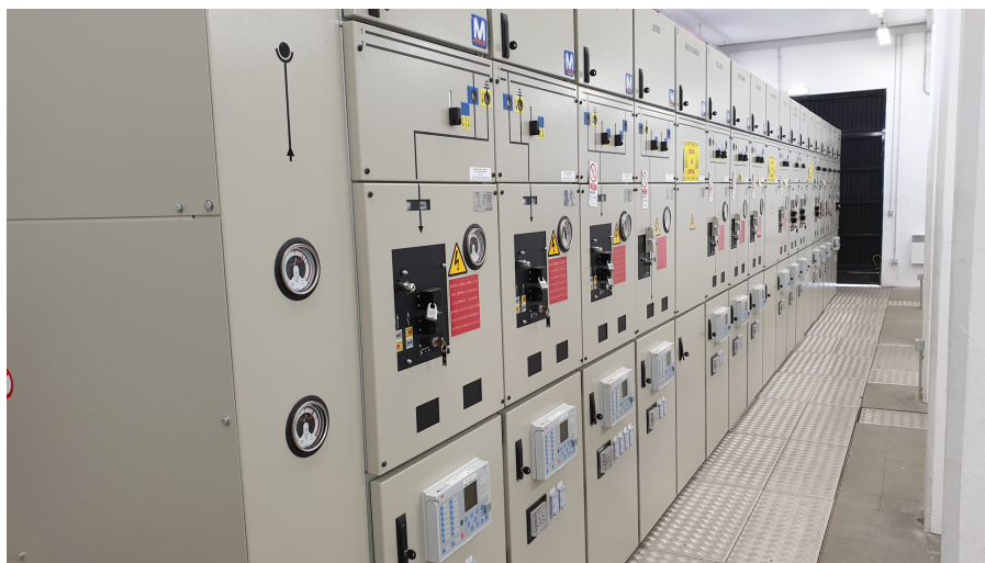
Figura 17 - Frontal de celdas de 22 kV tras su instalación según disposición indicada.
