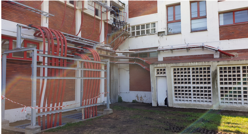
Figura 20 – Tendido de cables en la fachada exterior de la subestación.
