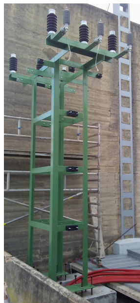
Figura 28 - Estructura de soporte para embarrado.
