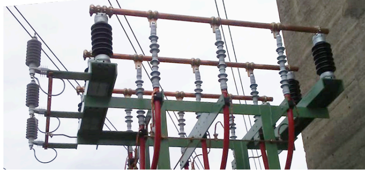
Figura 27 – Detalle de transición entre cable aislado y embarrado, con aisladores de soporte y autoválvulas de 22 kV a la izquierda de la imagen.
