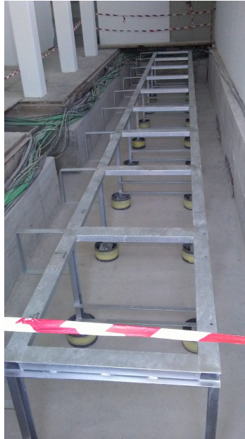
Figura 29 - Bancada para Celdas de 22 kV.
