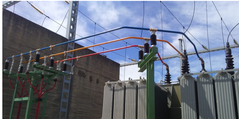
Figura 25 - Embarrado correspondiente al transformador 3 ejecutado según planos adjuntos.
