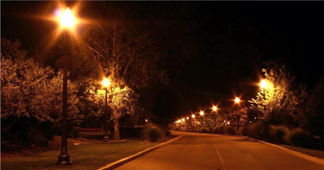
Figura 3.3.- Instalación de luminarias de vapor de sodio de alta presión.
