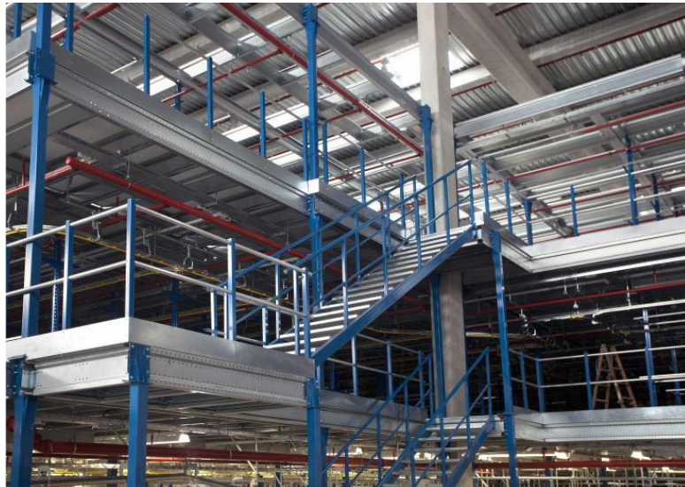
Figura 1. Entreplanta de una nave
