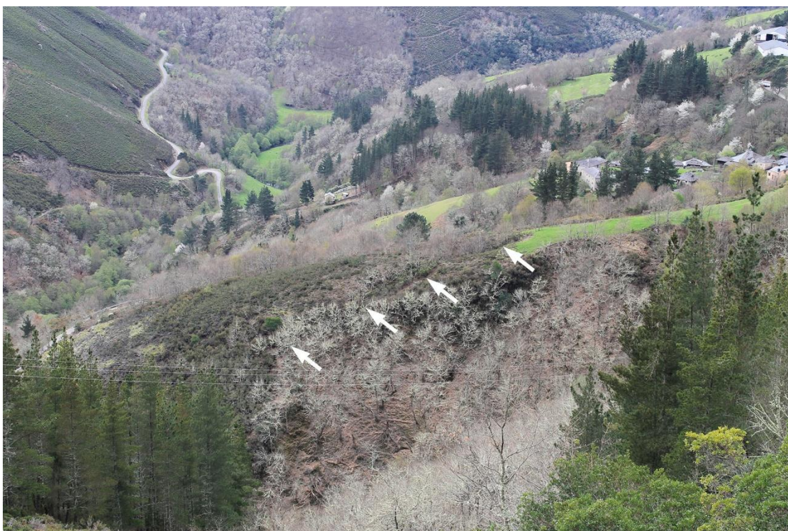
Figura 59: Vista de Piqueiros dende'l Noreste. Señálase la cárcava septentrional.
