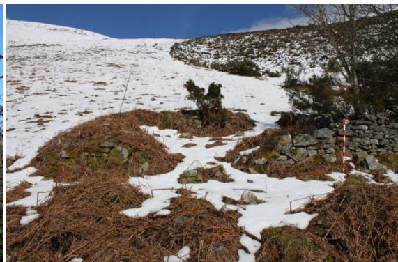
Figura 112: Santiello. Nivel habitual de conservación de les construcciones vaqueres.
