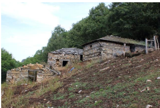
Figura 115: Cabañes d'El Candal con muros mixtos de piedra y tueros.
