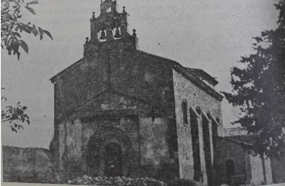
Fig. 100. Fotografía de la destrucción del pórtico de Cenero, 1936
