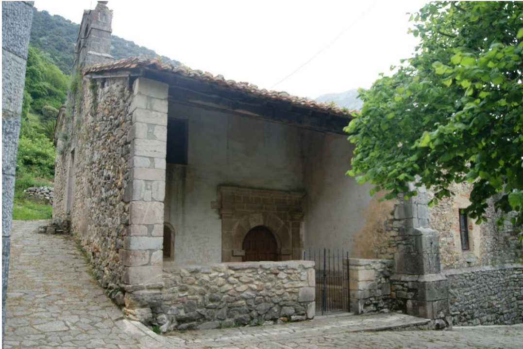
Fig.2. Exterior de la iglesia parroquial de Cuñaba
