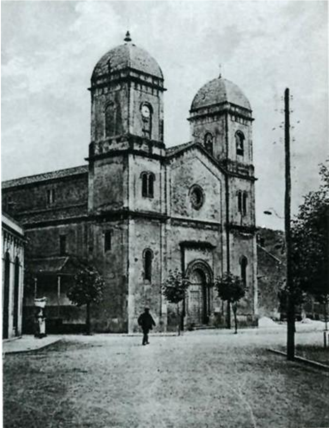
Fig. 121. Iglesia de San Pedro de La Felguera, construida en el siglo XIX.
