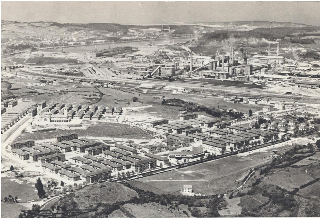
UE AÉRIENNE D'AVILÉS (Asturies). L'I. N. I., entreprise industrielle d'État, a monté, à proximité du charbon asturien, et a mis en marche en 1955 la grande
