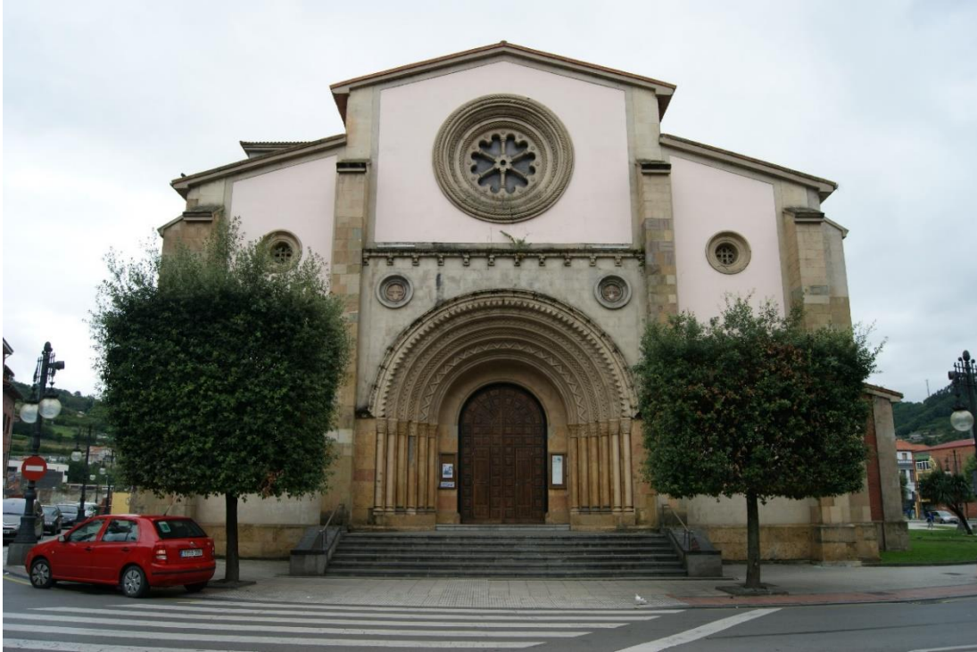
Fig. 131. Fachada principal de la iglesia parroquial de San Pedro, La Felguera
