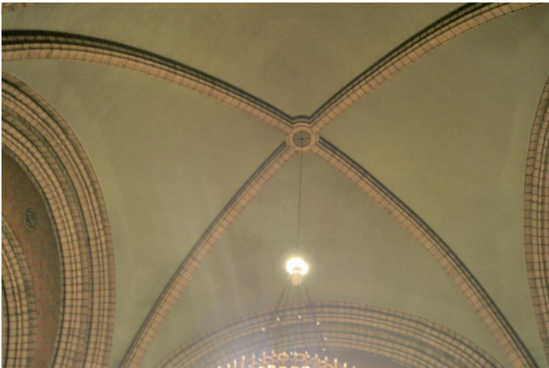
Fig. 129. Vista del interior de Santa María de Valdediós, donde se puede apreciar la solución del crucero y detalle de la bóveda de crucería en San Pedro de La Felguera
