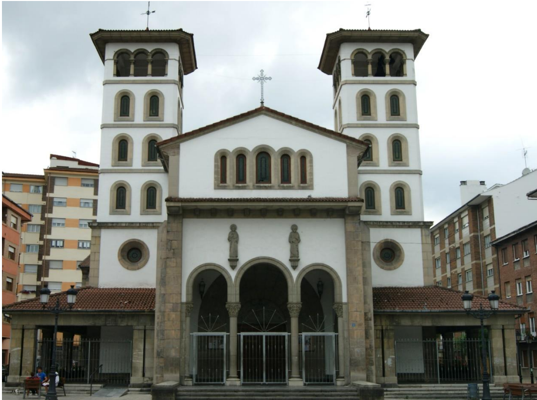
Fig. 156. Fachada de San Andrés de Linares, El Entrego
