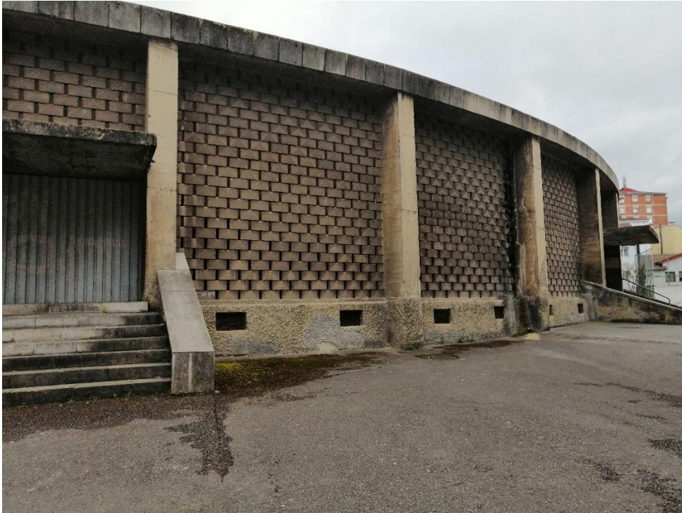
Fig. 289. Muro perimetral de la iglesia de Jesús Obrero
