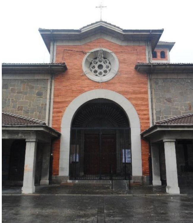
Fig. 174. Fachada de San Martín
