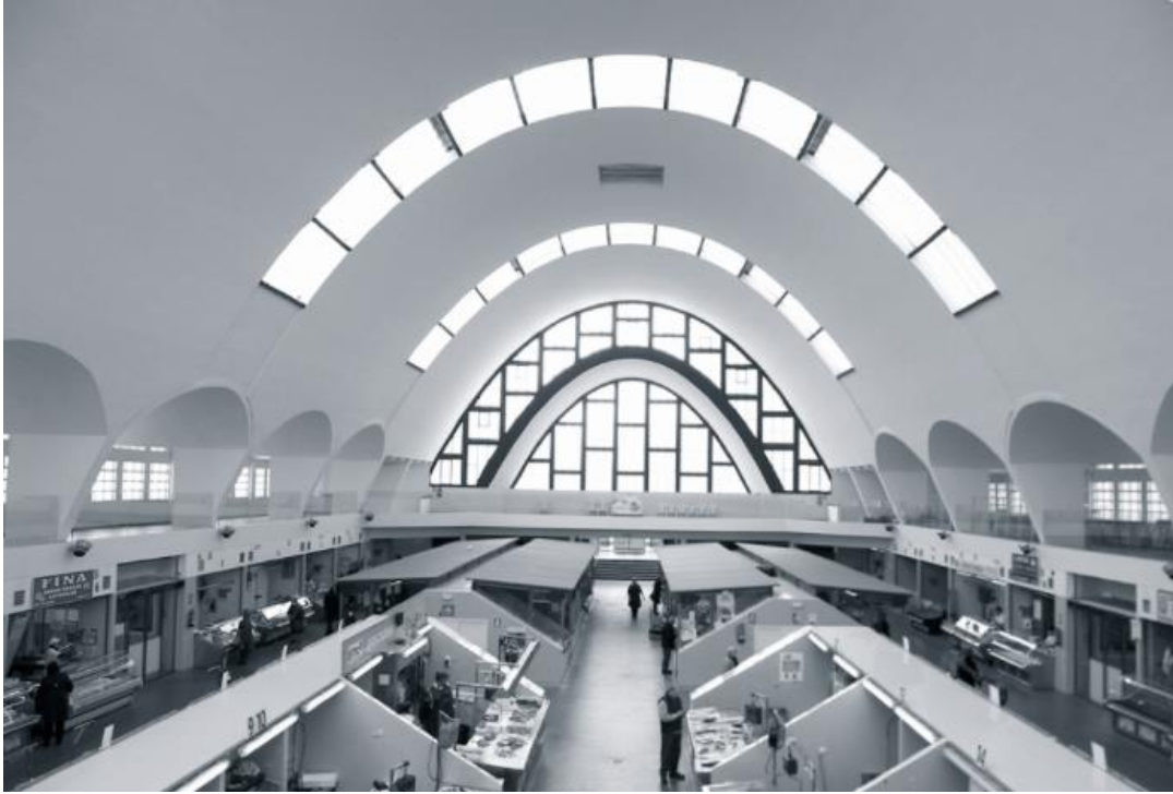
Fig. 188. Interior del Mercado de San Agustín, A Coruña
