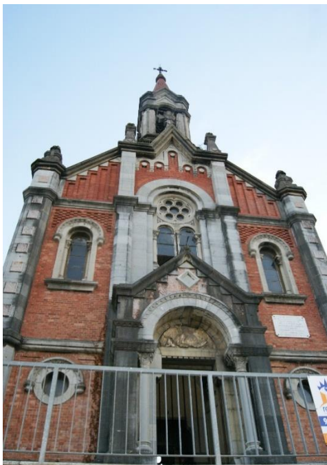
Fig.198. Fachada de la antigua iglesia de Santa Bárbara, en 2012.
