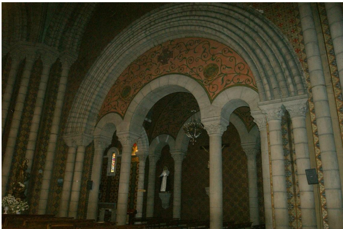
Fig. 138. Arcada lateral del crucero de San Pedro de La Felguera
