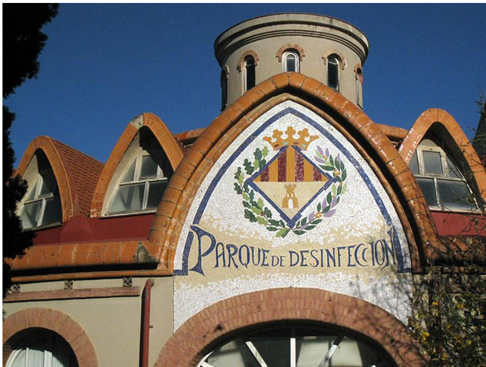
Fig. 187. Vista del Parque de desinfección de Tarrasa con la cupulilla
