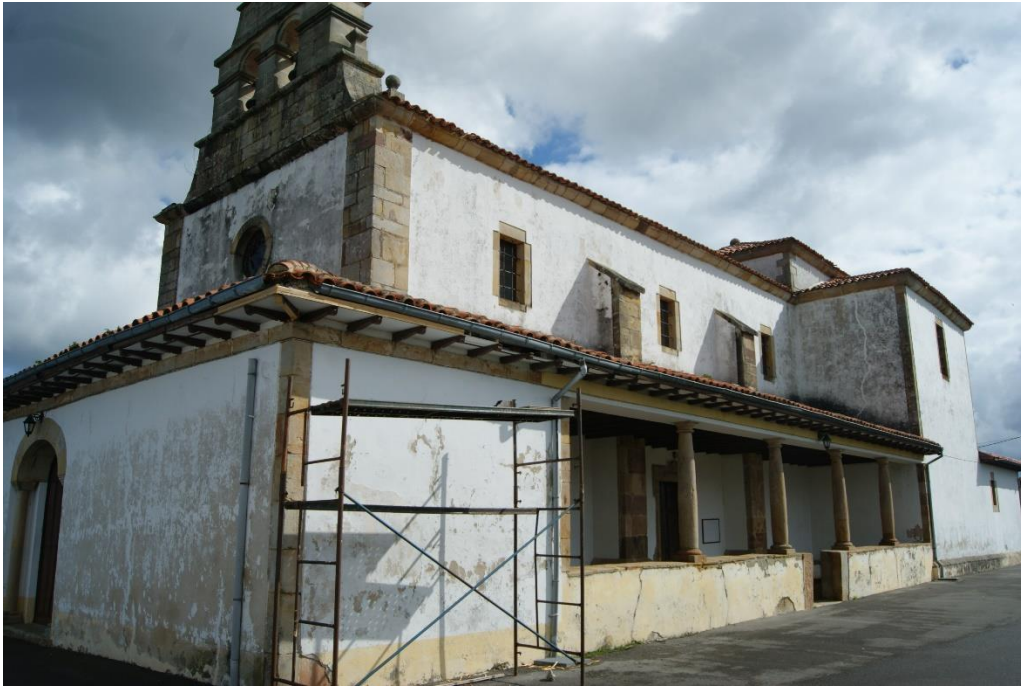
Fig. 93. Vista de los pórticos sur y oeste, San Vicente, Lué.
