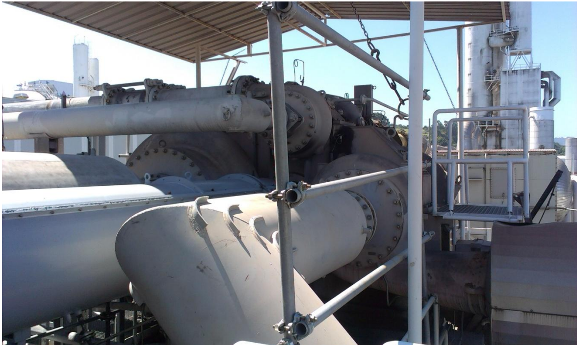
Figura 4.14. – Comparación entre una etapa de compresión del BAC y una del BLAC.
