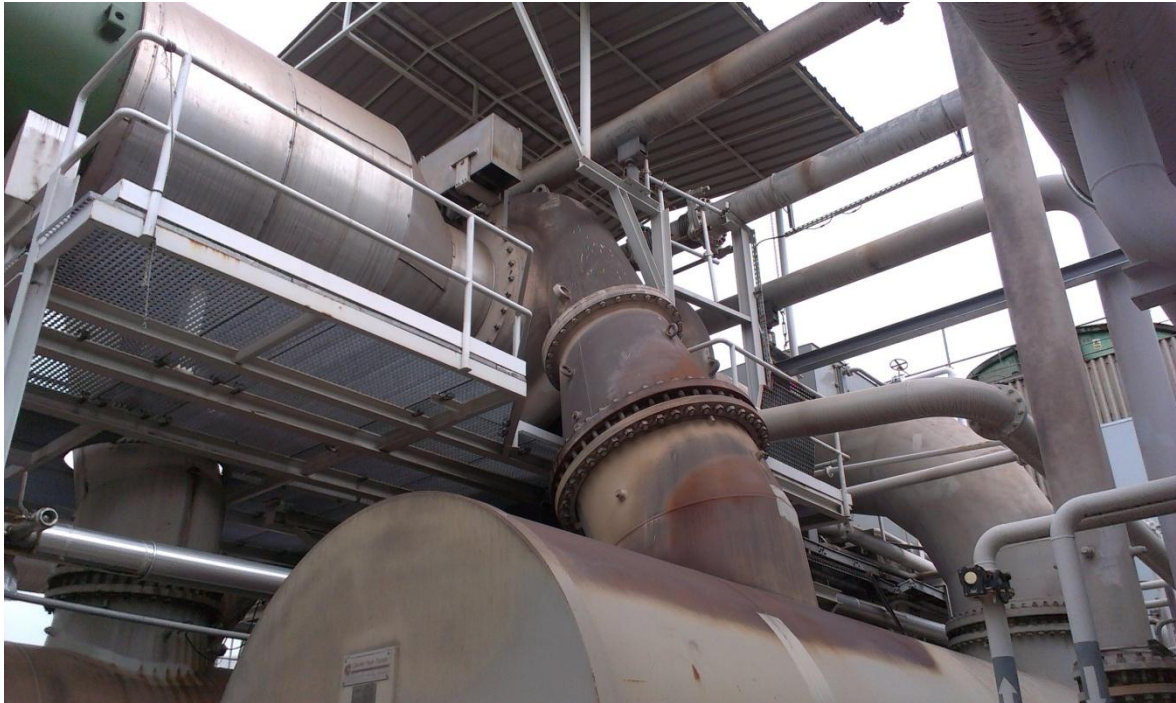
Figura 4.8. – Primera etapa de compresión del BLAC
