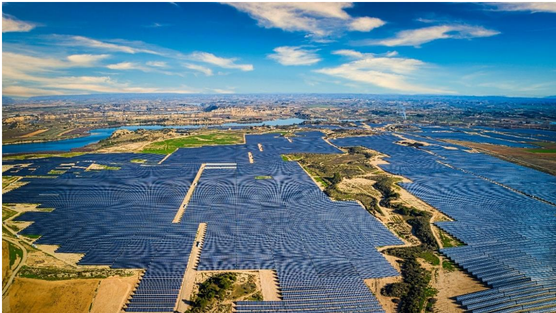
Figura 5: Parque fotovoltaico de Zaragoza (Aragón)
