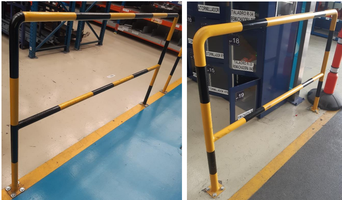
Figura 4.7. Barandillas de taller sin estandarizar con diferente altura y pintado.
