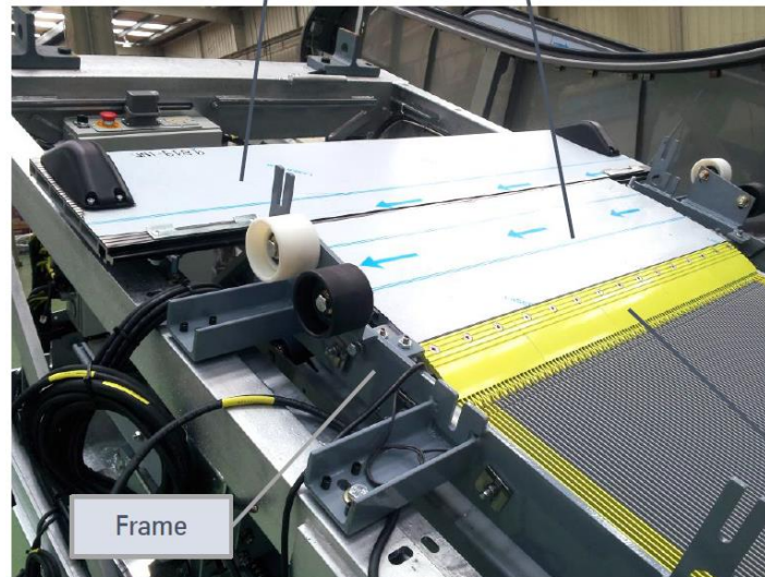
Figura 2.5. Colocación de las pisaderas.
