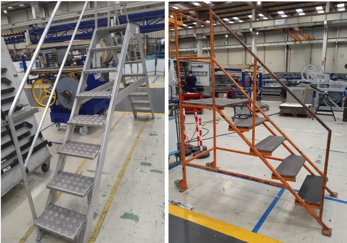
Figura 4.35. Escaleras sin estandarizar con diferente forma y altura.
