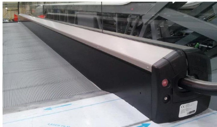
Figura 2.6. Disposición de zócalos y perfiles.
