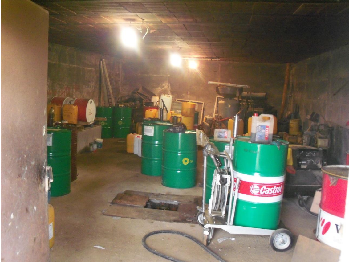
Figura V.10. Fotografía del hueco interior en el que se encuentra un depósito enterrado. Localización más desfavorable para exposición a aire interior
