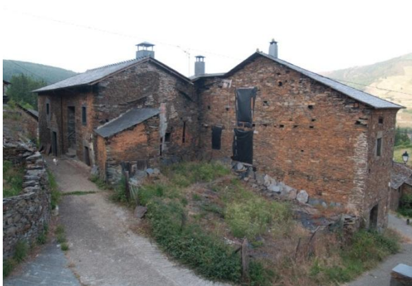
Fig. 92. Argul. Solar con evidencias de una construcción desaparecida. Se observa su impronta en los muros de las construcciones adyacentes.
