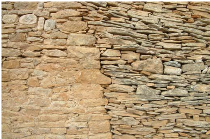
Fig. 4. Dos unidades estratigráficas diferentes en un paramento (Mileto, 2007)
