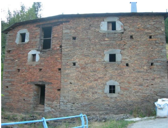
Figs. 77-80. Diferentes ejemplos de construcciones tradicionales en las que se aprecia una estratigrafía muraria. 77: Villapedre (Navia). 78 - 79: Argul. 80: Lixóu.
