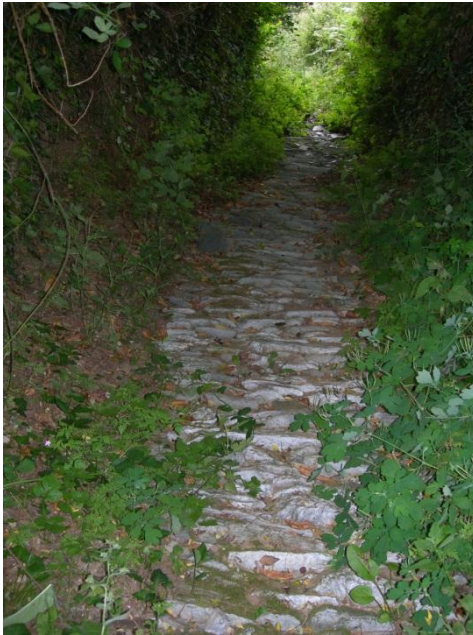
Figs. 93 y 94. 93: Antigo camino de Pelorde a Argul. Restos en superficie del empedrado en “chapa-cuña”. 94: Machón del puente de madera de Sequeiros
