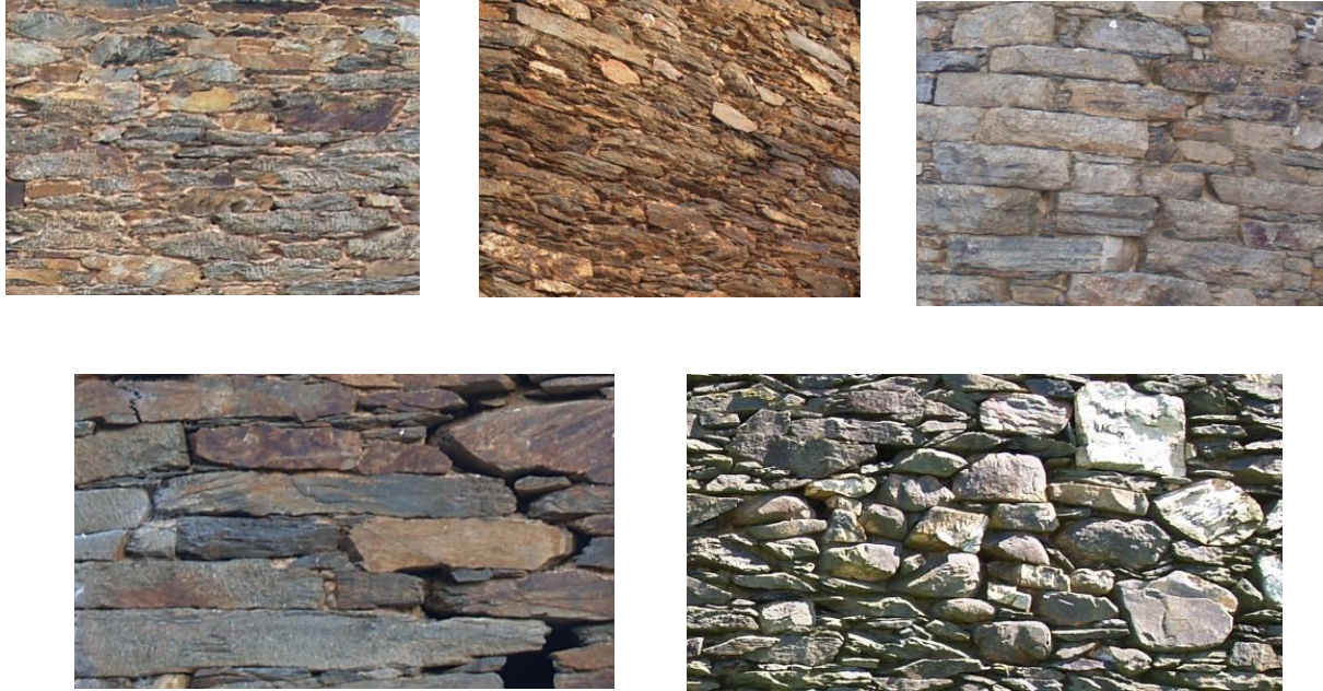
Figs. 81 a 85: Diferentes tipologías de mampostería de pizarra en edificios de Pesoz.
