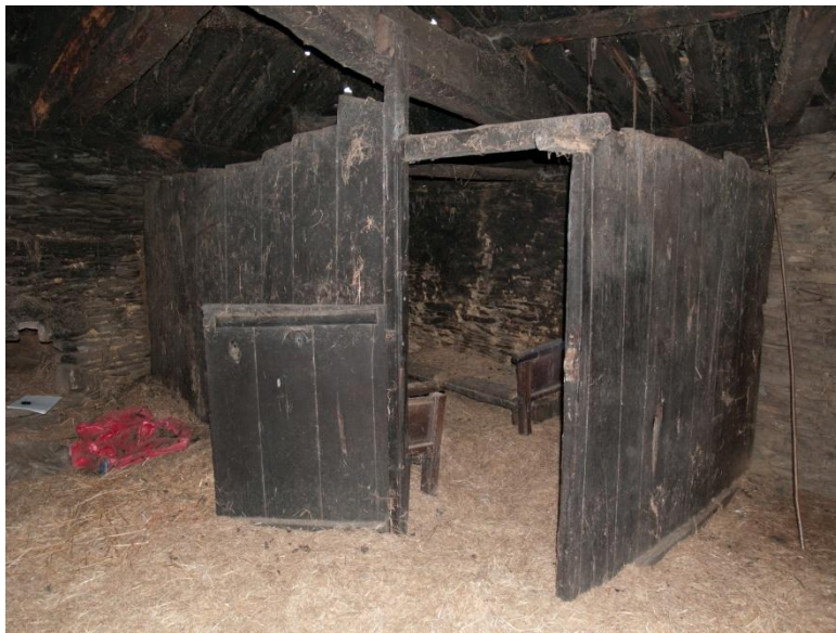
Fig. 48. Vilabriye. Casa Tomé. En el interior de esta casa aún se conserva su cocina original, la lareira . Cerrada por tablonces de castaño, en el interior, encontramos el escano rodeando el fuego. Se aprecian las paredes y el techo ennegrecidos por el humo. A la izquierda, aunque ha perdido las piedras de cantería, los chancares, se conserva el horno de cocer pan.
