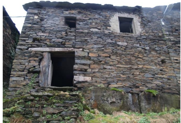
Figs. 77-80. Diferentes ejemplos de construcciones tradicionales en las que se aprecia una estratigrafía muraria. 77: Villapedre (Navia). 78 - 79: Argul. 80: Lixóu.
