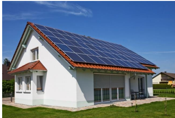
Figura 4.4.- Instalación fotovoltaica sobre un tejado [28].
