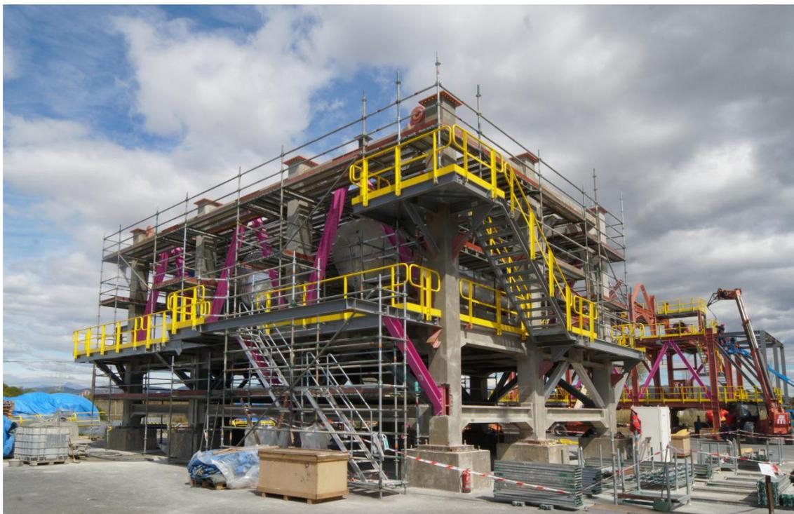
Figura 10: Construcción modular de una unidad de vacío para la empresa BP [14].
