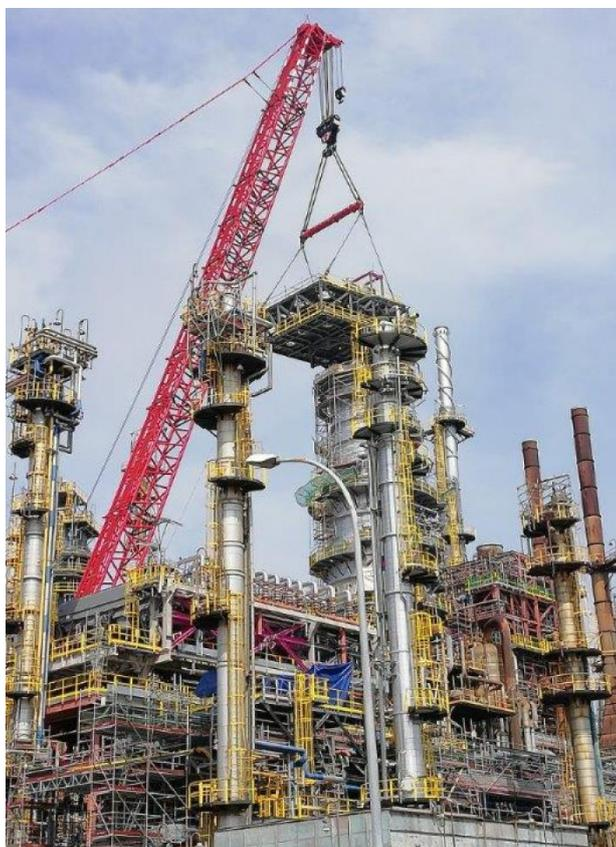
Figura 11: Instalación de una unidad de vacío para la empresa BP [14].
