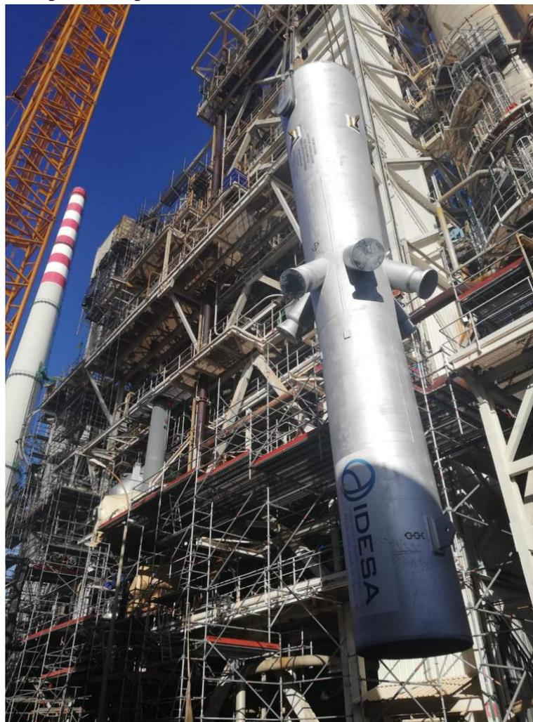
Figura 9: Instalación de un catalyst cooler para la empresa Galp [13].
