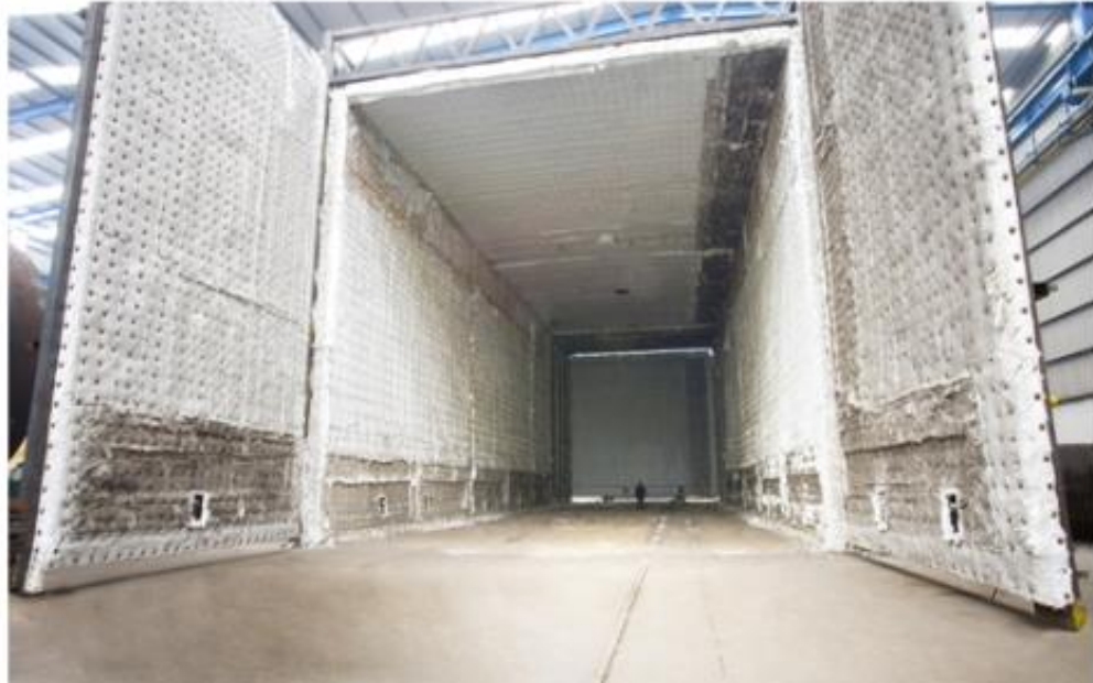
Figura 5.51.- Horno de las instalaciones de la empresa, tamaño 12m x 12,5m x 40m
