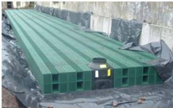
Figura 20. Depósito de infiltración (Fuente: iagua.es)
