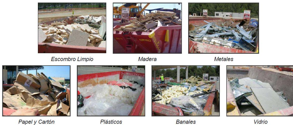
Figura 5. Ejemplo de fracciones de RCD separadas en obra [27]
