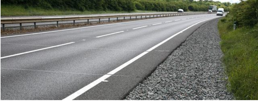
Figura 21. Dren filtrante en autopista (Fuente: carnellgroup.co.uk)
