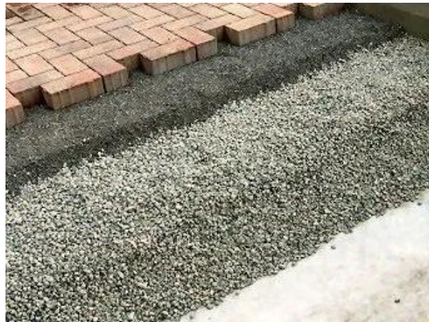
Figura 17. Estructura de un firme permeable (Fuente: sudsostenible.com)
