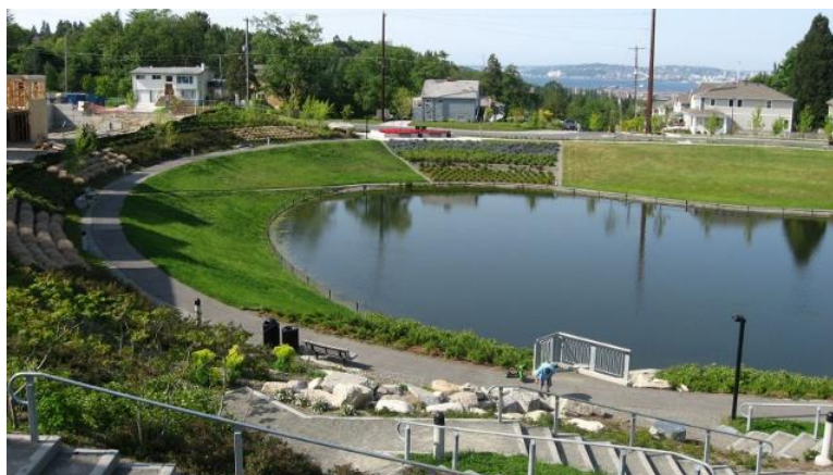
Figura 25. Estanque de retención (Fuente: sudsostenible.com)
