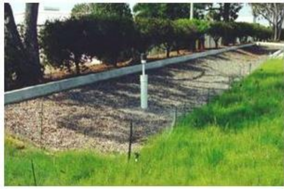
Figura 19. Zanja de infiltración experimental (Fuente: iagua.es)
