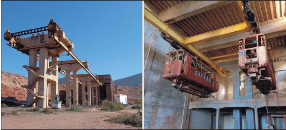
FIGURA 19. Vista general de la estación terminal de tierra, desde el oeste (izq.), en la que se aprecia la escalera de acceso a los vehículos; y vista del interior de la nave de hormigón con los restos de los dos vehículos automotores que se conservan, desde el oeste (dcha.) (archivo de los autores, 2019).
