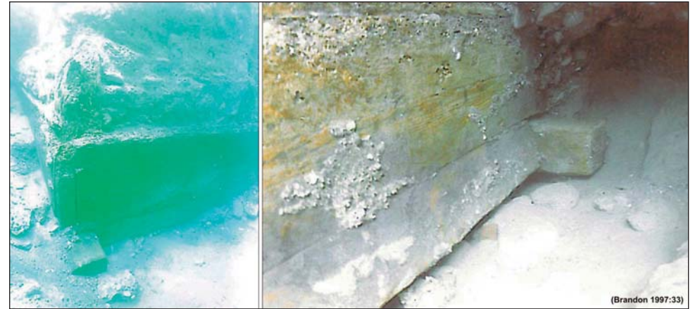
FIGURA 73. Imágenes del estado de los cajones del “área K” de Sebastos durante las investigaciones arqueológicas submarinas. Izquierda, ángulo noreste del K5. Derecha, ángulo sureste del K3 (fotografías 3 y 4 de Shuki Ovadia, en BRANDON 1997:33). Es de resaltar la subsistencia de la madera bajo el agua a pesar de los dos milenios transcurridos.
