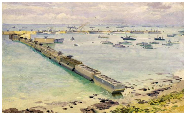
FIGURA 57. Aspecto de un Mulberry en funcionamiento, plasmado por Stephen Bone, hijo de Sir Muirhead Bone, en el que se aprecian las barcazas/Phoenix perfectamente alineadas, configurando un rompeolas (Royal Museum Greenwich).
