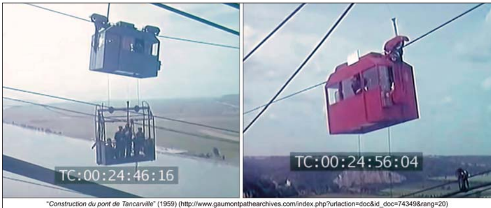
FIGURA 23. Fotogramas con el prototipo automotor de NEYRPIC durante la construcción del puente de Tancarville en 1959 (www.gaumontpathearchives.com).
