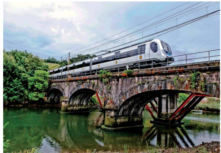
FIGURA 60. Fotograma del puente sobre el Urumea a su paso por Loyola; las dos pilas centrales estaban cimentadas sobre cajones sumergibles de hormigón armado (Foto de Juanjo Olaizola, tomada en http://historiastren.blogspot.com/2013/06/el-puente-de-loiola.html ).
