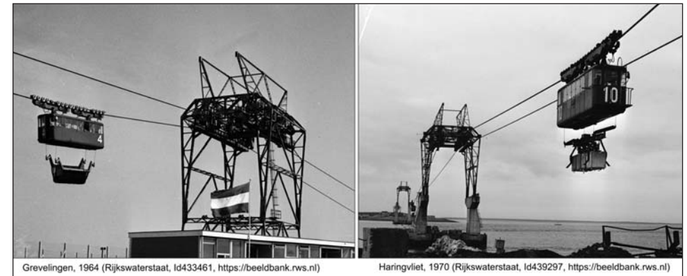
FIGURA 24. Imágenes de los teleféricos de NEYRPIC en la construcción de los diques de Países Bajos en Grevelingen en 1964 (izq.) y Haringvliet en 1970 (dcha.) (Rijkswaterstaat, https://beeldbank.rws.nl).
