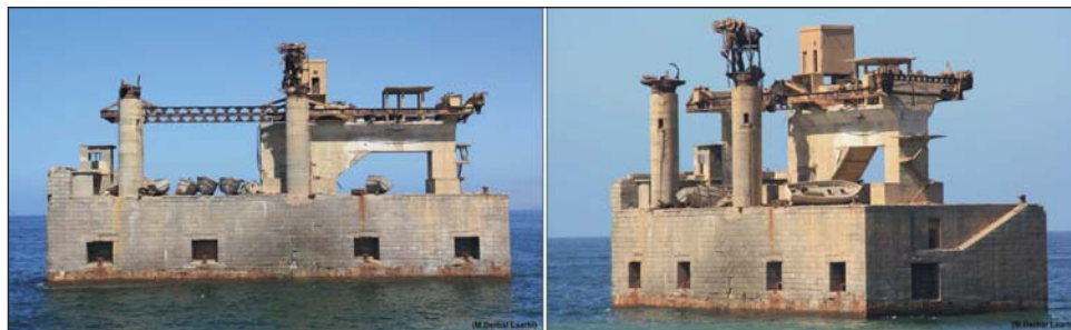
FIGURA 16. Vistas del dique muelle en la actualidad, desde el suroeste (izq.) y desde el sureste (dcha.) (M. Derbal Laarbi, 2020), donde se aprecia claramente la disposición de los cuatro norayes.
