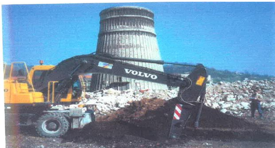
Figura 55. Realización de calicatas sobre escorias de piritas (RYMOIL, 2001).
