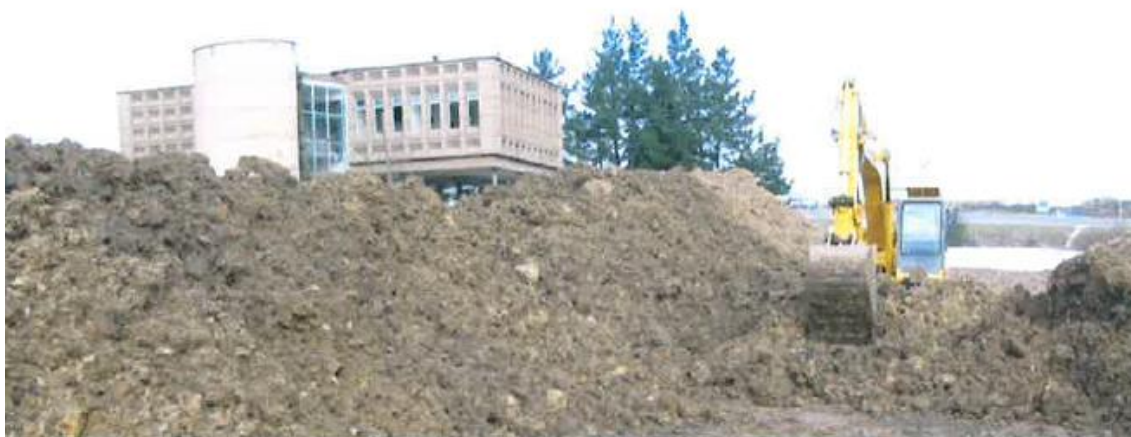
Figura 61 Excavación y formación de biopilas en el emplazamiento de Química Alba (Consulnima, 2009).
