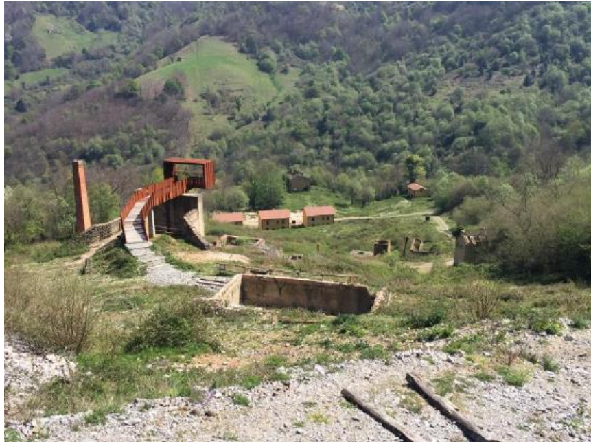
Figura 69. Vista general de la mina de Texeo (Colina, García, Salgado, y Sierra, 2017).
