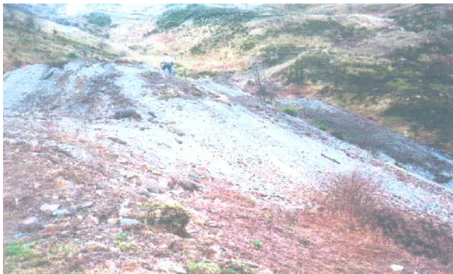
Figura 44. Vista de la parte superior de la escombrera norte (RYMOIL).
