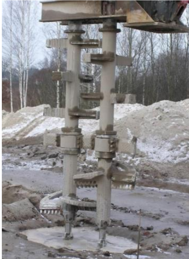
Figura 74. Barrena doble de Deep Soil Mixing (Elaboración propia).
