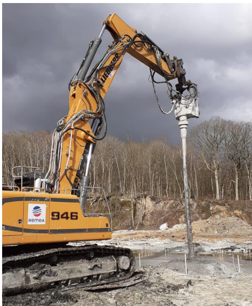
Figura 76. Equipo de Deep Soil Mixing con barrena simple (Elaboración propia).
