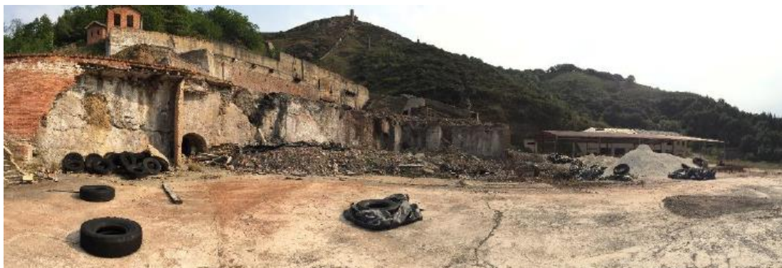
Figura 66. Panorámica de las instalaciones de La Soterraña (Colina, García, Salgado, y Sierra, 2017).
