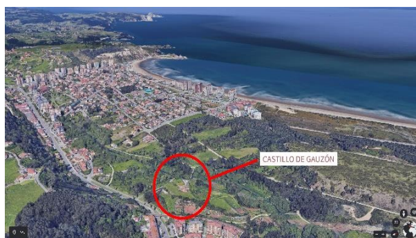
Figura 2: Emplazamiento del castillo de Gauzón sobre el Peñón de Raíces (Castrillón). Imagen de Google Earth.
