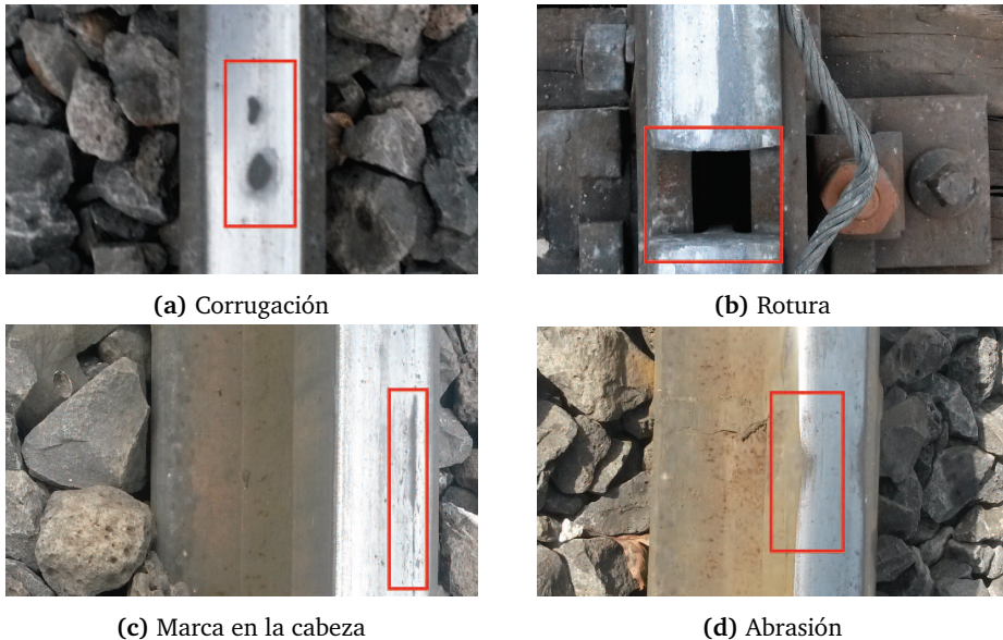
Figura 2.16: Diferentes tipos de defectos por desgaste del carril. Imágenes extraídas de [35]. ©2017, IEEE.
