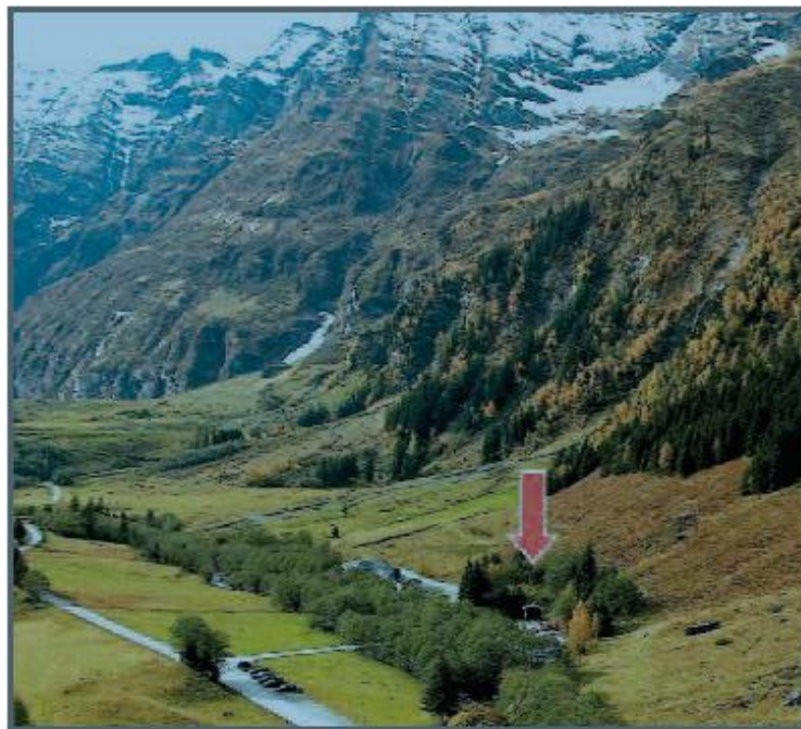
Fig. 3.5 - Fotografía de la entrada de la mina subterránea de Mittersill, en la cual, tanto la infraestructura, vestuarios, comercios y oficinas, se encuentran bajo tierra, ya que está ubicada en pleno corazón de los Alpes austriacos. Fuente: Schmidt, 2012 .
