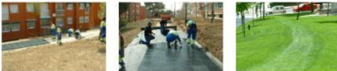
Figura 2.57 Instalación de celdas de drenaje bajo pavimento. Zona de captación deprimida. Fuente: Ayto. de Madrid.
