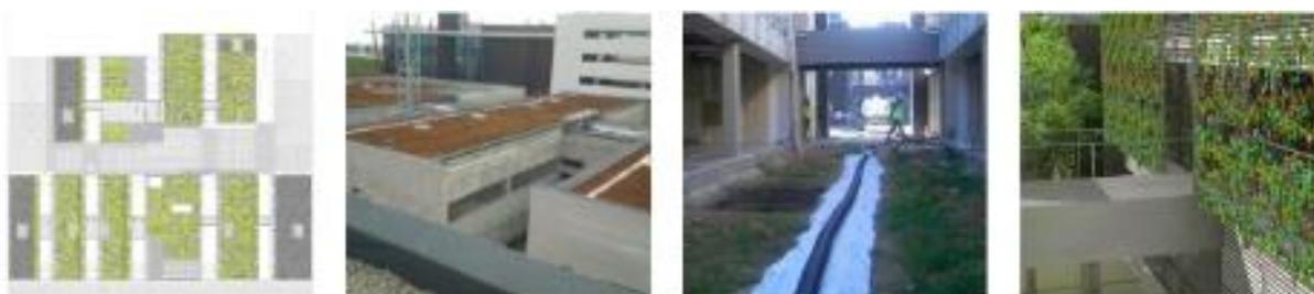
Figura 2.60 Cubiertas vegetales, zanja drenante en patio y fachada vegetada. Fuente: Ayto. de Palma de Mallorca.
