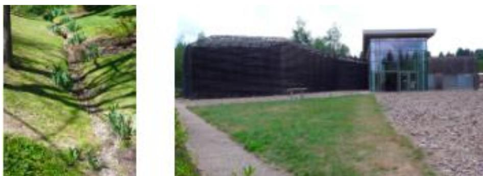
Figura 2.5 Zanja de infiltración y franjas filtrantes. Fuente: (Checa & De Pazos, 2018)
