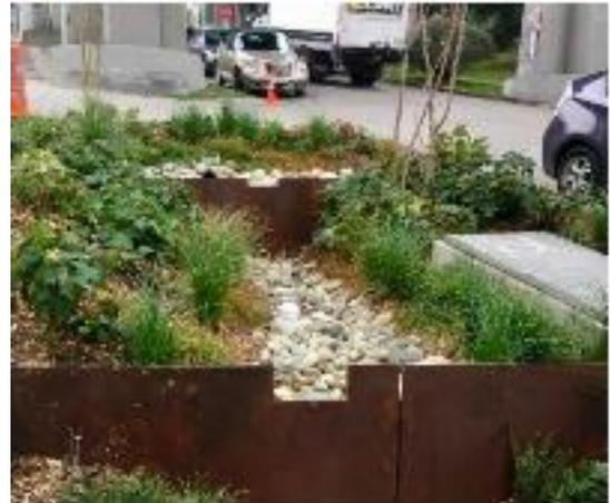
Figura 2.53 Cuneta vegetada en Seattle (EE.UU.). Fuente: *Stephen C. Grey & Associates*.
