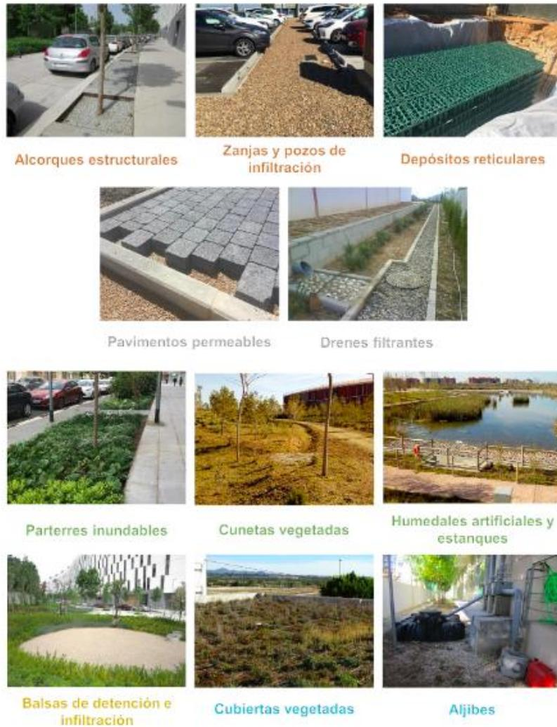
Figura 2.10 Tipos de SUDS. Fuente: (Del et al., 2000)
