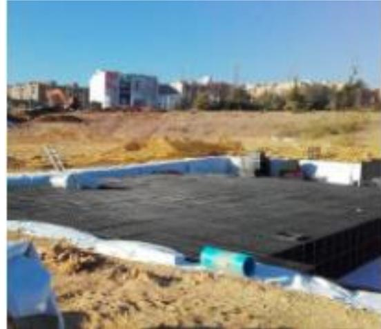
Figura 2.43 Depósito reticular en el Parque Central de Valencia. Fuente: *HidroStank*.
