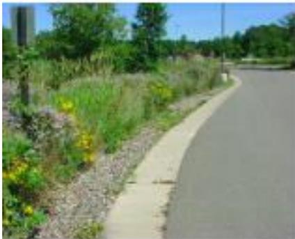
Figura 2.37 Zanja de infiltración en Minnesota.
