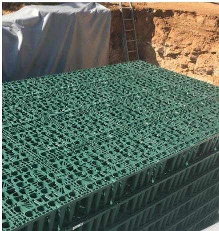
Figura 2.44 Depósito reticular en Valencia. Fuente: *GreenBlueManagement*.
