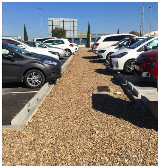
Figura 2.39 Zanja de infiltración en Sevilla. Fuente: *GreenBlueManagement*.
