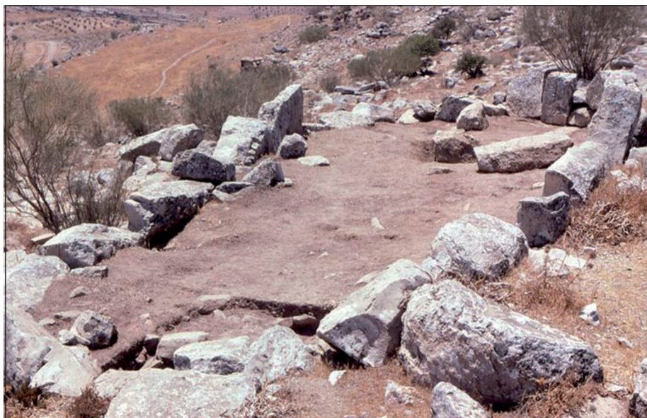
Fig. III Una de las casas con planta de forma ovalada del sector oriental
