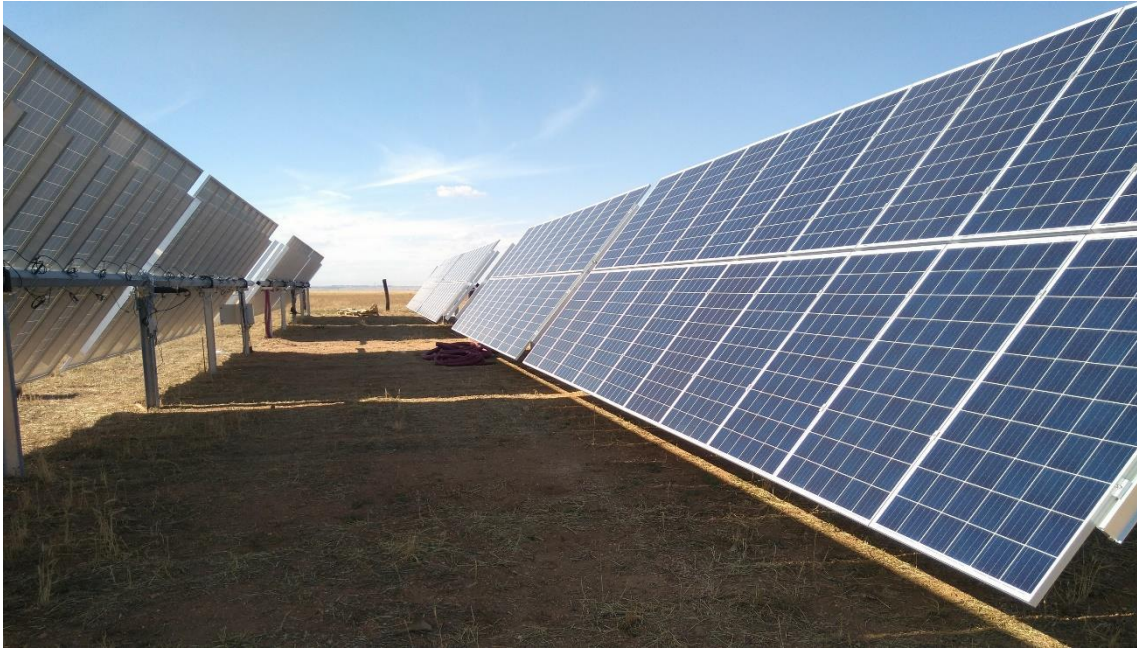
Figura 5. Hileras de seguidores Solares.
