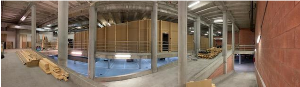
Figura 32. Vista panorámica del túnel.
