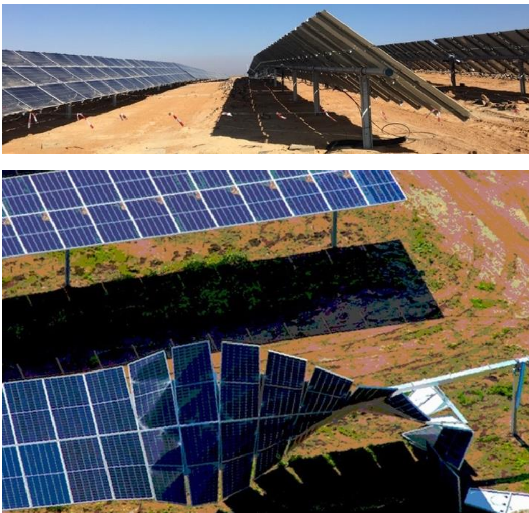
Figura 1. Campo de seguidores solares y efectos de la acción dinámica del viento.
