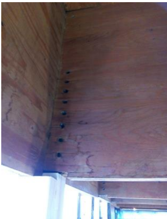
Figuras 4 y 5: Aplastamientos locales de testas en las zonas de las fijaciones.
