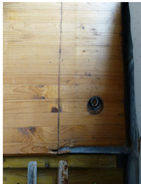
Figuras 4 y 5: Aplastamientos locales de testas en las zonas de las fijaciones.
