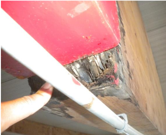
Figuras 2 y 3: Tipología y alcance de los daños en las piezas de madera de las piscinas objeto de inspección.
