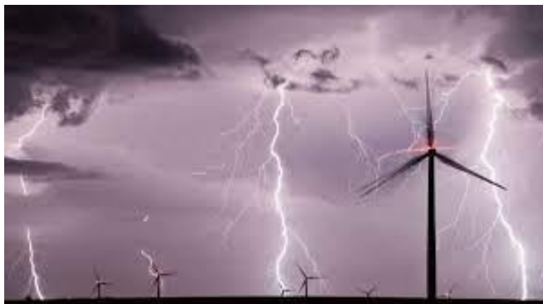
Ilustración 28. Parque eólico bajo tormenta.
