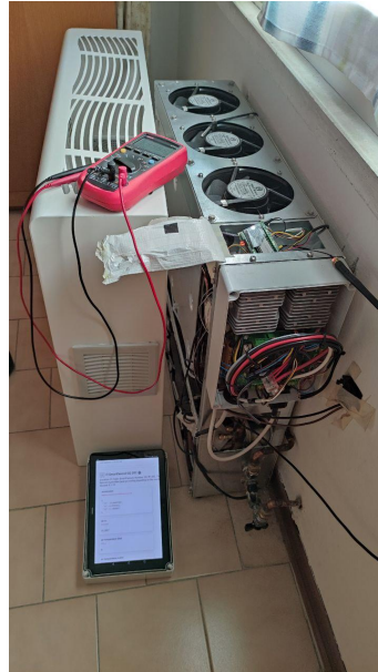
Figura 4.12 FC durante la instalación de los sensores en el caso de estudio B.
