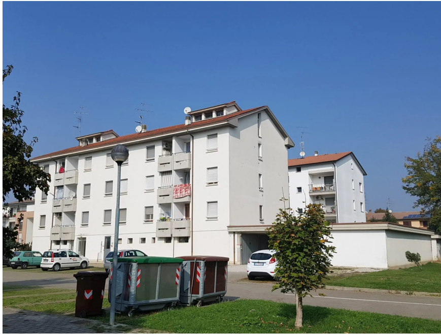
Figura 4.6 Edificio de viviendas del caso de estudio B: Bagnolo, Piano (Italia).
