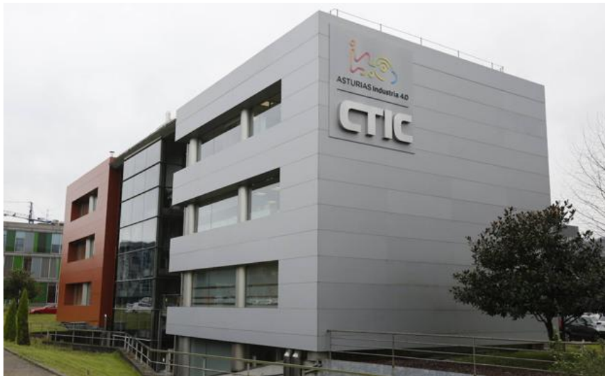
Figura 4.1 Edificio de oficinas del caso de estudio A: CTIC Centro Tecnológico; Parque Científico Tecnológico de Gijón.
