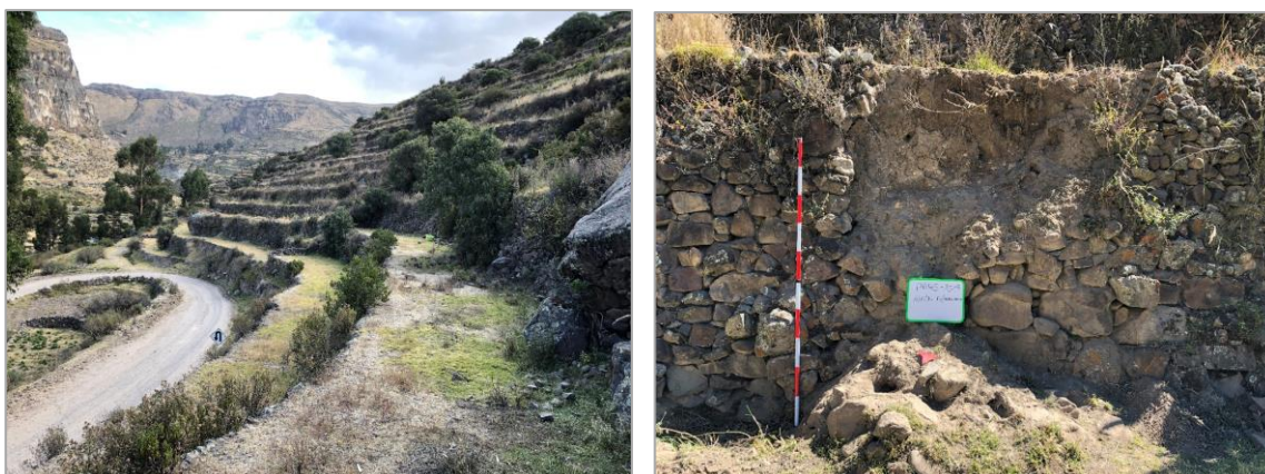
Figura 140: Vista general del sector y detalle de la cara frontal del andén intervenido (Andén A-Andamarca).
