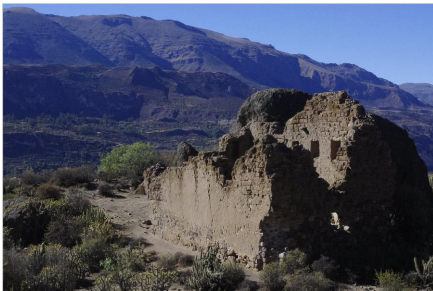
Figura 89: Imagen de la construcción de Molle Quiro en las inmediaciones de Jaspata y con la presencia de una gran roca en la parte posterior.
