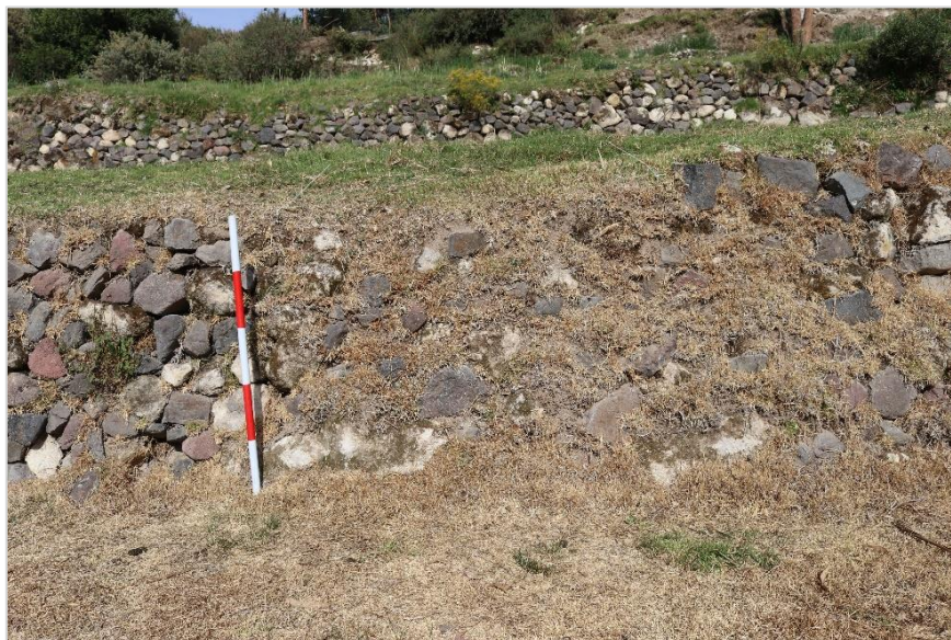
Figura 206: Vista del muro en las condiciones originales.
