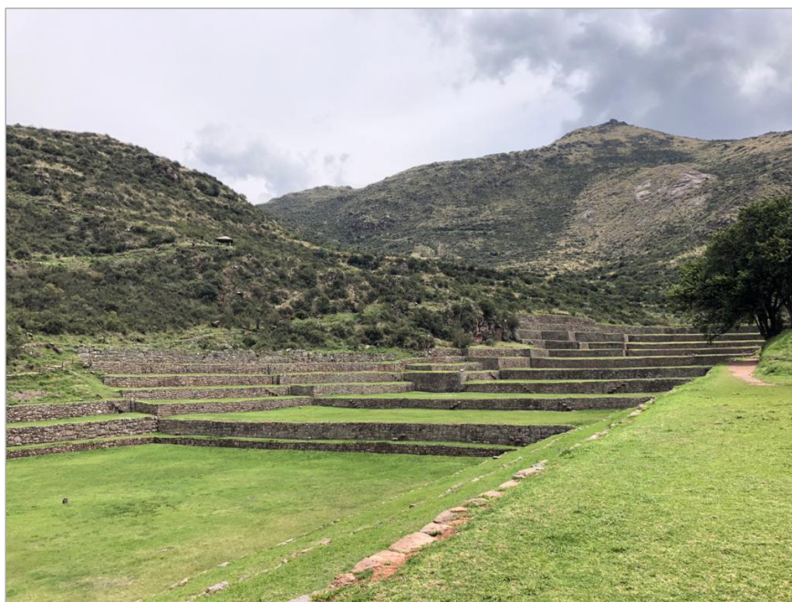
Figura 98: Andenes incaicos con tacas y pacchas en el sitio de Tipón (Cusco).
