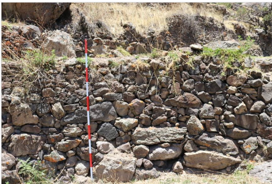
Figura 194: Paramento del muro de sostenimiento del Área 1-Lambracha.
