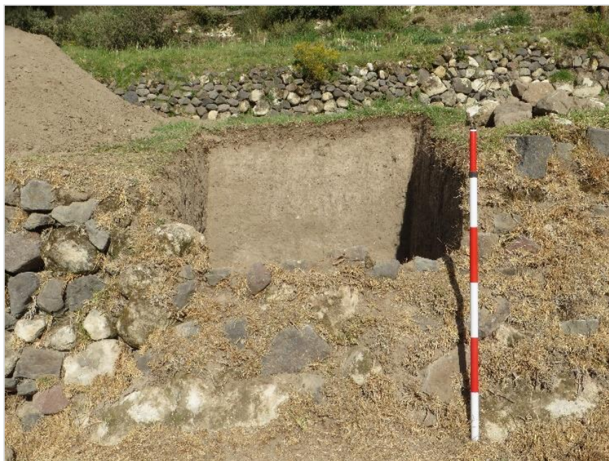
Figura 208: Vista frontal del muro o UE 05.
