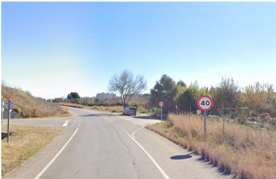
Figura 3.4: Carretera de entrada a Quart de Poblet
