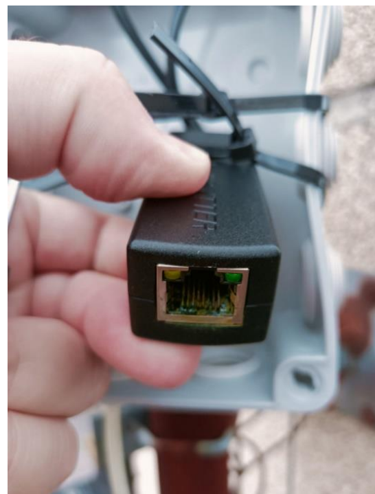
Ilustración 12 Daños en el inyector PoE
