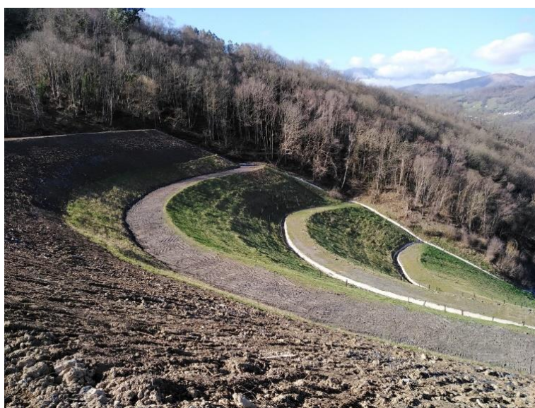
Figura 72. Sector 3 de la escombrera de Figaredo, que se encuentra en rehabilitación (foto tomada en noviembre de 2019)
