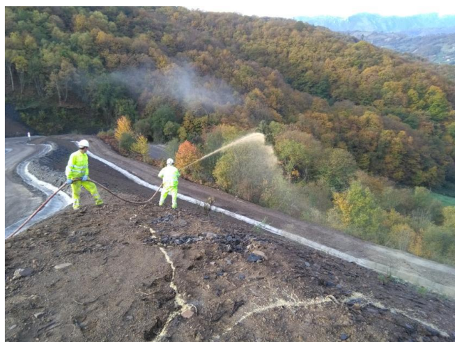
Figura 119. Proyección de la hidrosiembra (foto tomada en octubre de 2019)
