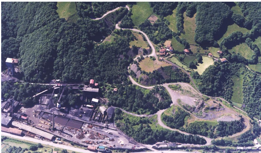
Figura 99. Vista de la escombrera de Sarabia o sector 1 de Figaredo (2010)
