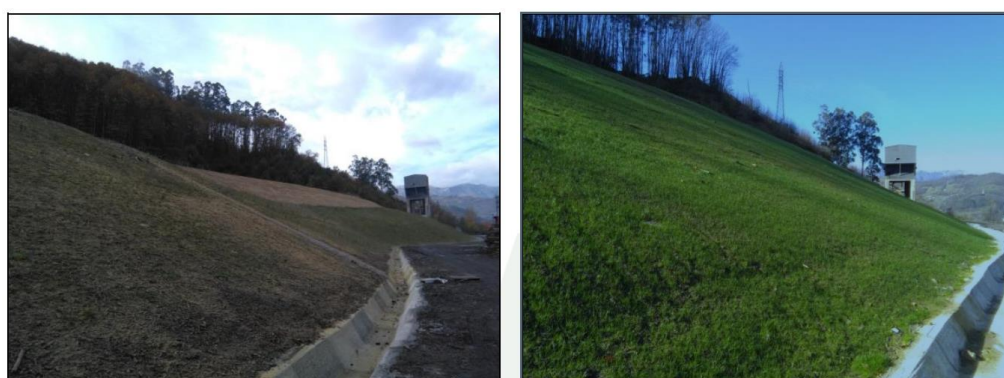
Figura 110. Resultados de la hidrosiembra después de seis meses en el Sector 2 (desde noviembre de 2016 hasta mayo de 2017)
