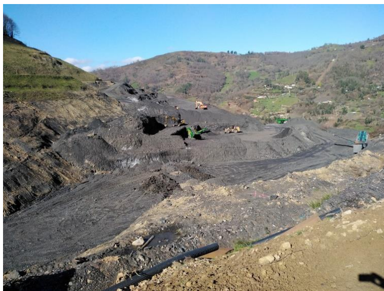
Figura 71. Sector 4 de la escombrera de Figaredo, que se está removiendo para recuperar carbon (foto tomada en noviembre de 2019)
