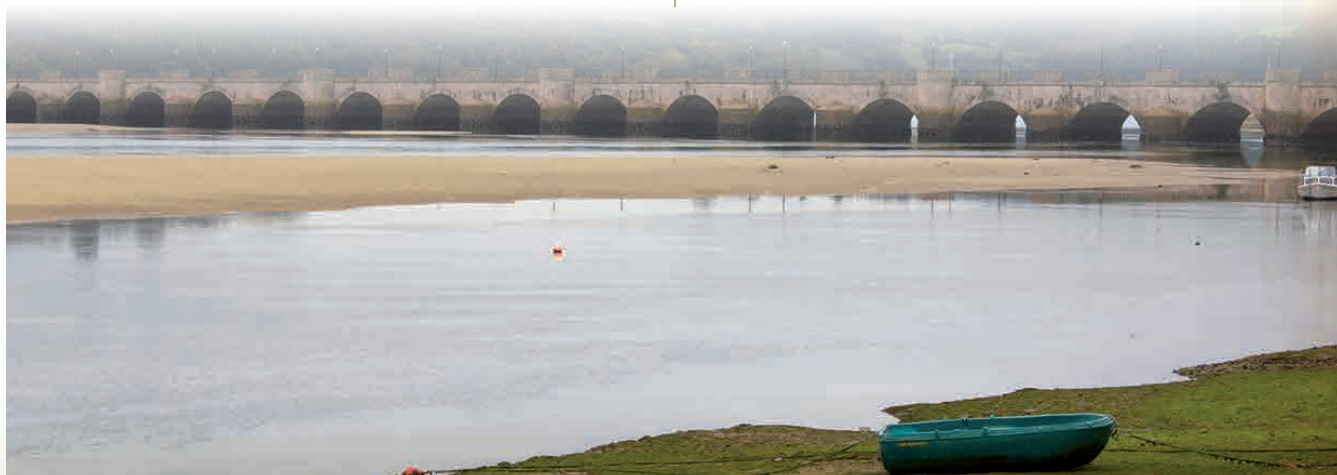
Puente de La Maza.
