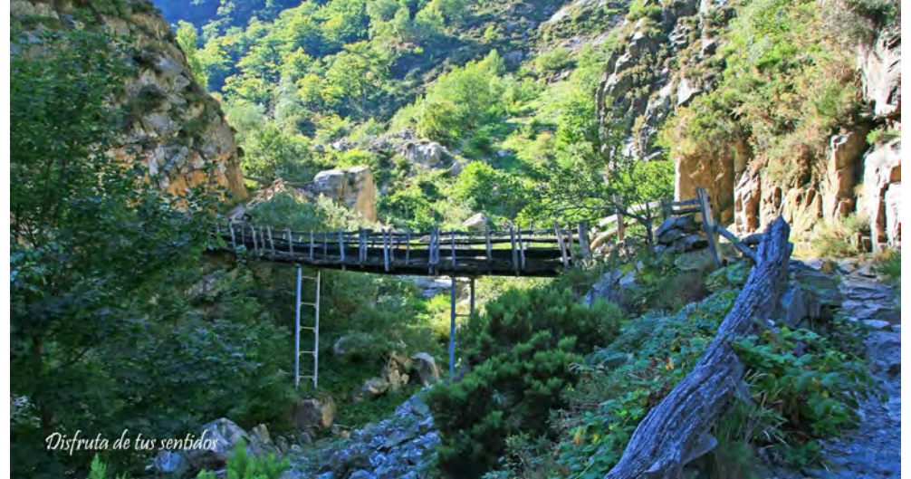
Puente La Calabazosa (Ruta de los Arrudos) - Caso
