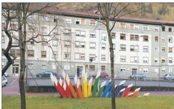
FIG. 19. Una barriada marginada desde su inicio, con fuertes problemas constructivos, debido a las prisas con las que se levantaron los bloques en la carretera antigua de Langreo a Mieres, a unos tres kilómetros del centro de esta ciudad, consiguió a mediados de los años ochenta, no sólo una rehabilitación solvente de las fachadas de los edificios, sino también de las viviendas y, sin que lo pensaran nunca, un parque, levantado sobre una pequeña escombrera, en la entrada de la barriada según se viene de Mieres. Todo se debió a un Plan de Rehabilitación Integral impulsado por el entonces consejero competente, Emilio Murcia, en cuyo honor pusieron su nombre al fallecer éste prematuramente. Es de poca entidad superficial, y los elementos florales son todavía muy discretos, no así su cromatística ornamentación escultórica.
